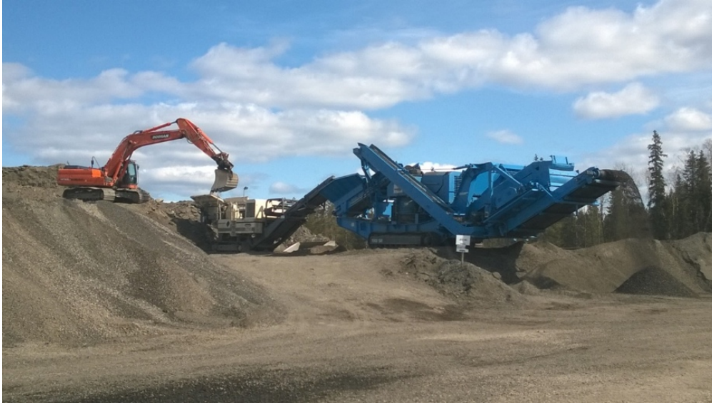
KUVA 4. Murskausasema Lokotrack 95 + Terex Pegson
