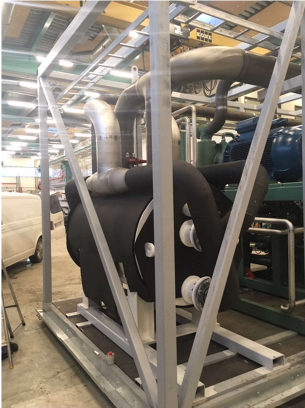
Kuva 15. Vahterus Plate & Shell Heat Exchanger Combined Findrin tehtaalla eristystyöväi- heessa.
