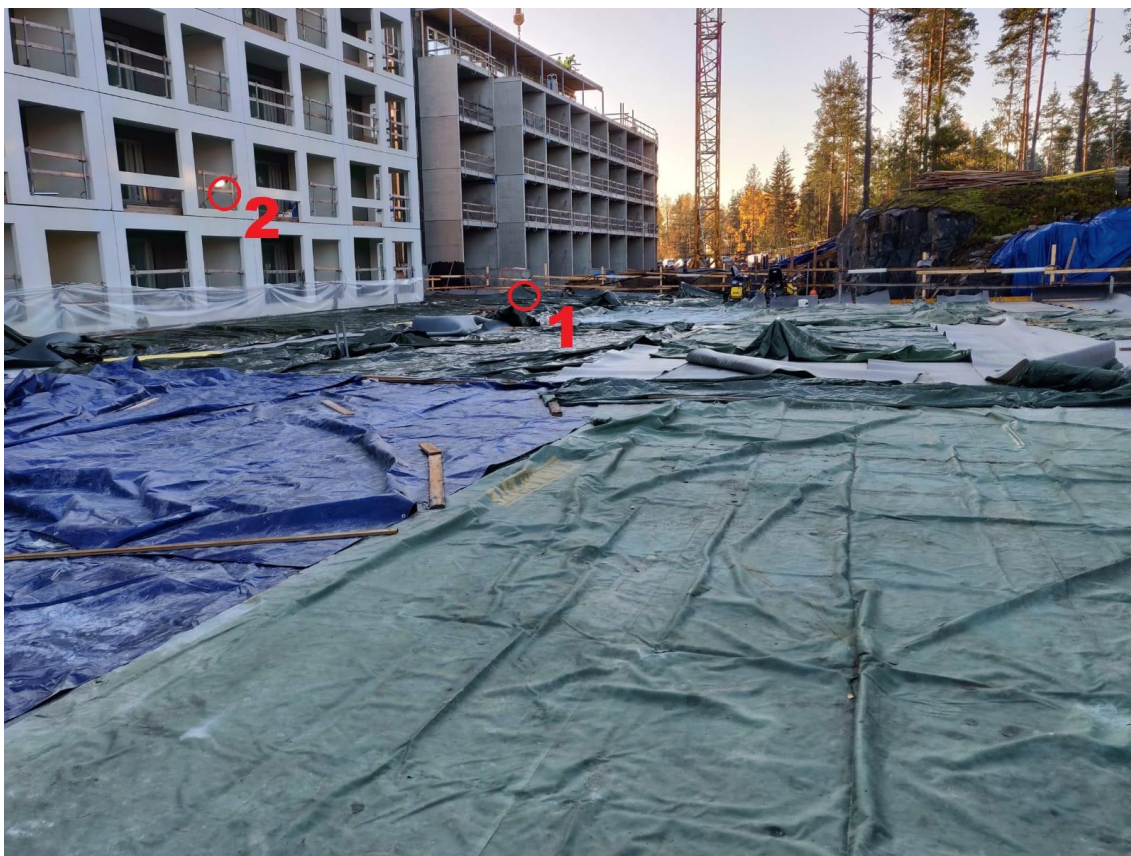
Kuva 9 Holvi valun jälkeisenä päivänä peiteltyinä. Kohta 1 on mittalaitteen sijoituspaikka ja kohta 2 tukiaseman sijoituspaikka
