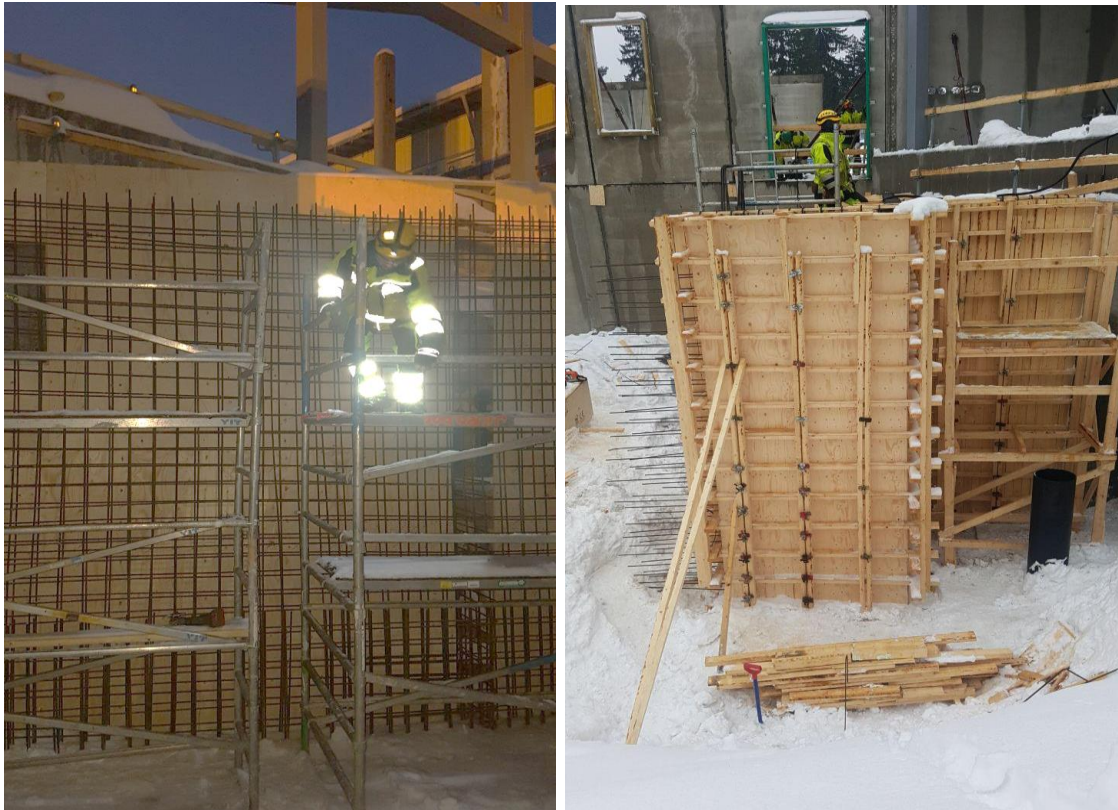
Kuva 30 Muotin pystytys ja raudoitus.
