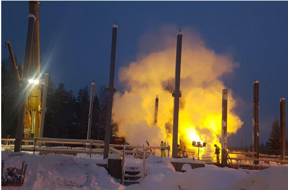
Kuva 23 Tukimuurin höyrytys, ilmaan nousee höyryä.
