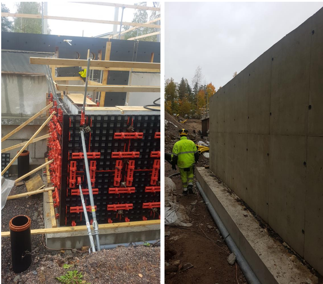
Kuva 3. Tukimuurin paikallavalu, Espoo. Rakentaja: Jerodos Oy
