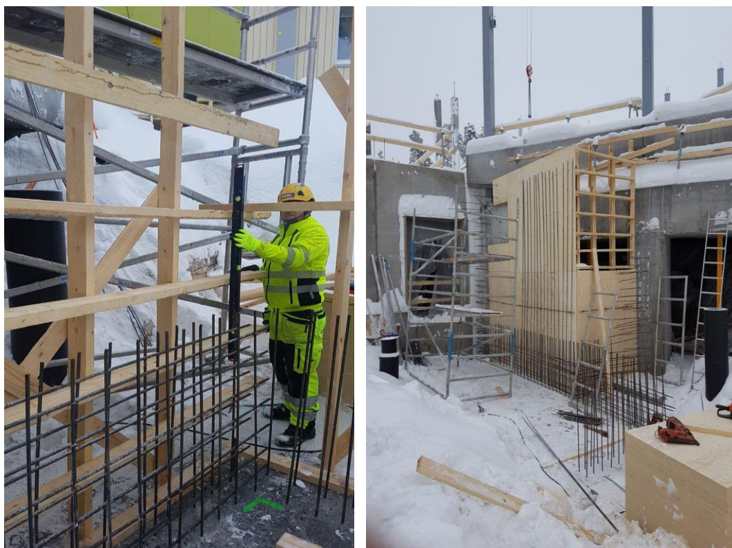
Kuva 27 Muotin rungon pystytys vaihe.
