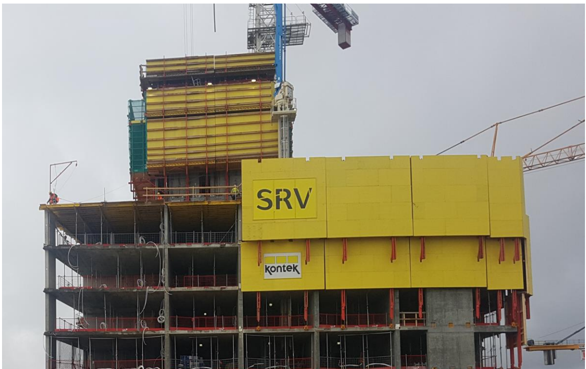
Kuva 4. Redin työmaalla otettu kuva, missä näkyy suurmuottien käyttö Majakan rakentamisessa. SRV, 14.09.2017.
