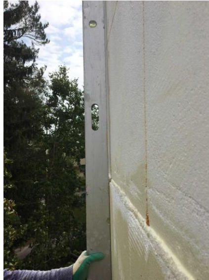
Kuva 23. Elementtien välisiä hammastuksia.
