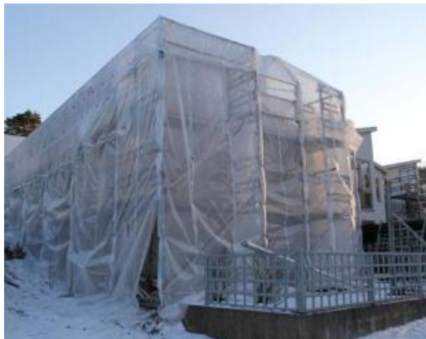
Kuva 10. Sääsuojatut telineet (Lahdensivu ym. 2012, 12).
