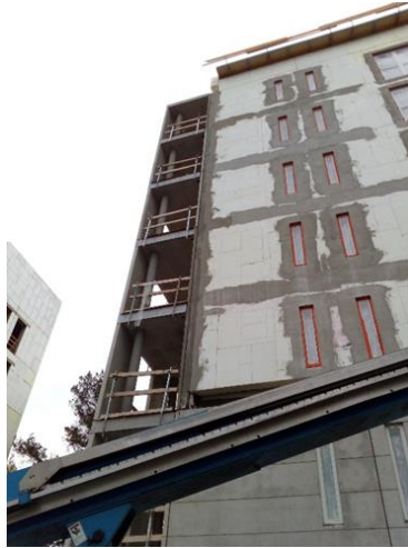
Kuva 35. Aukkojen vahvistuksia ja päättölistan asennus reunaan.
