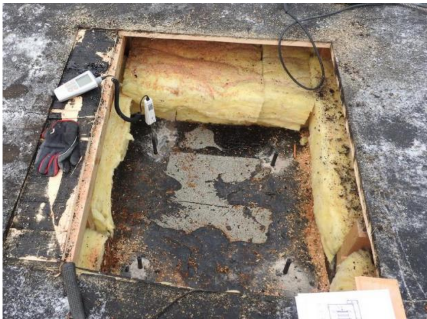
Kuva 16. Katon rakenneavaus yläpuolelta. Kosteusmittauksen pisteet M1–M4. [8]
