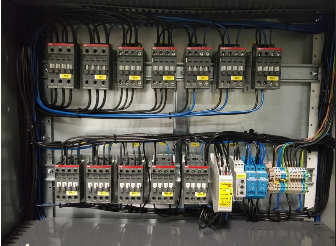
Kuva 20. Koestuslähtöjen kontaktorit ja apureleet.
