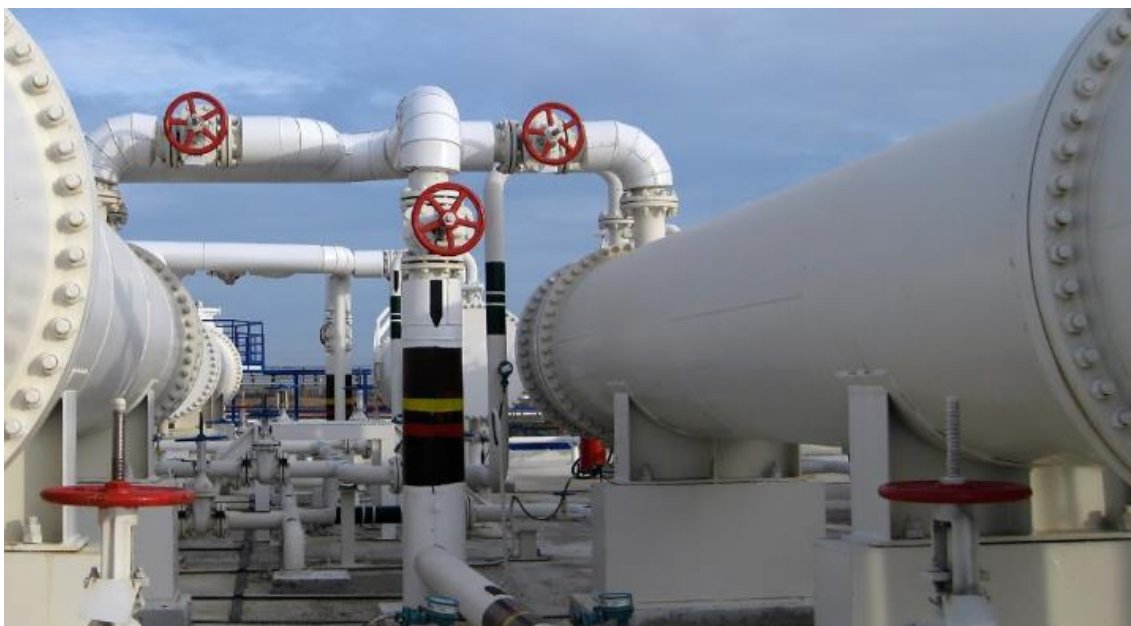
Kuva 19: Esimerkki lämmönsiirtimissä käytettävistä yhteistä. Kuvassa [15] yhteet on liitetty putkiston avulla muun prosessin osaksi.
