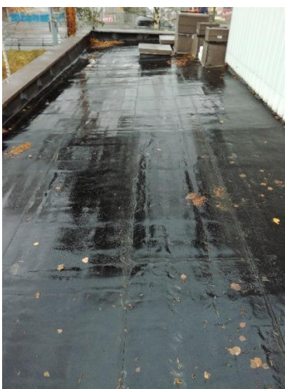
Kuva 19. Rakennuksen bitumikermikattoa (Tissari 2018-11-01)
