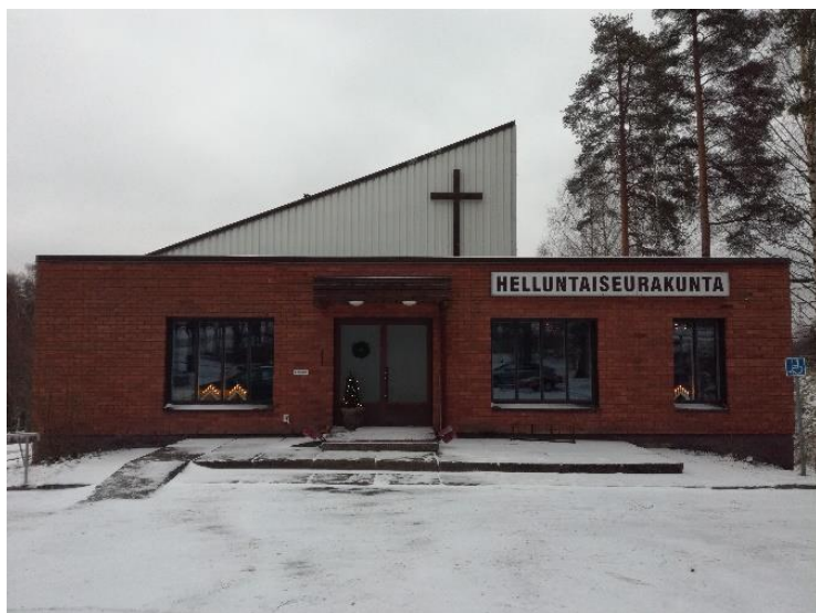
Kuva 20. Rakennuksen pulpettikatto (Tissari 2018-11-30)
