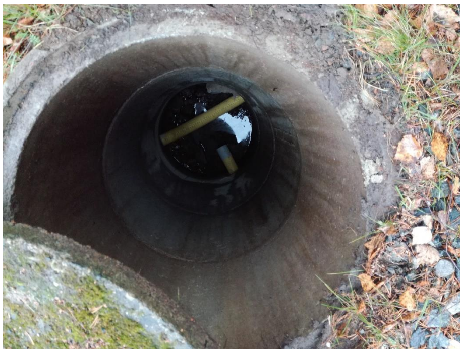
Kuva 9. Alkuperäinen salaojakaivo (Tissari 2018-11-01)
