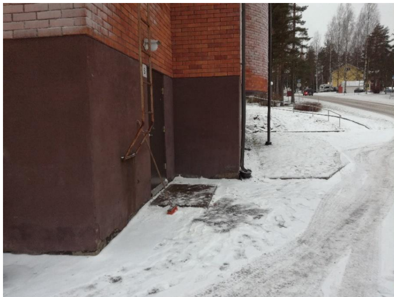
Kuva 8. Puutteelliset maanpinnan kaltevuudet (Tissari 2018-11-30)
