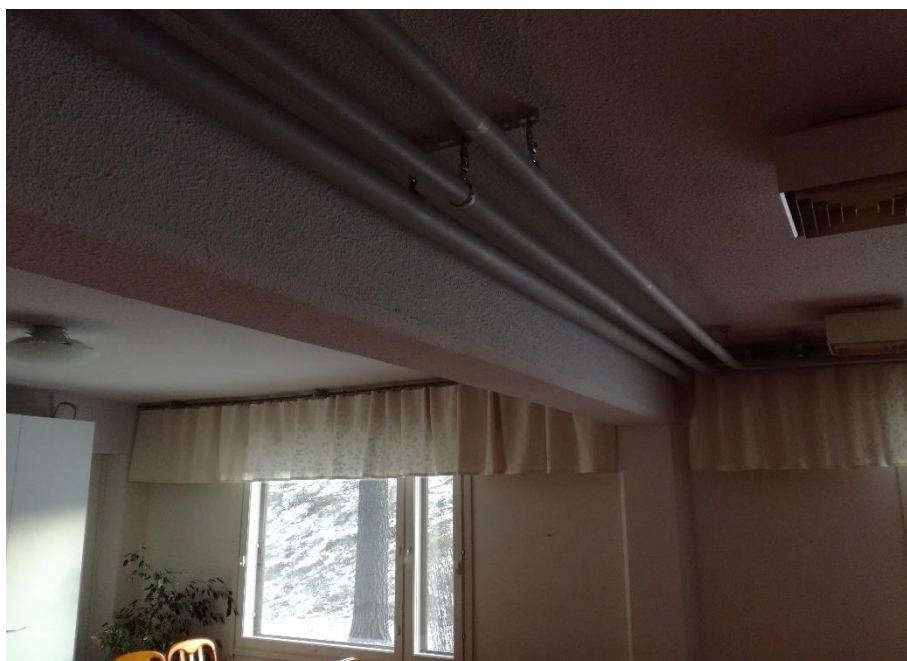
Kuva 13. Kellarikerroksen kantava pilari ja palkki (Tissari 2018-12-01)
