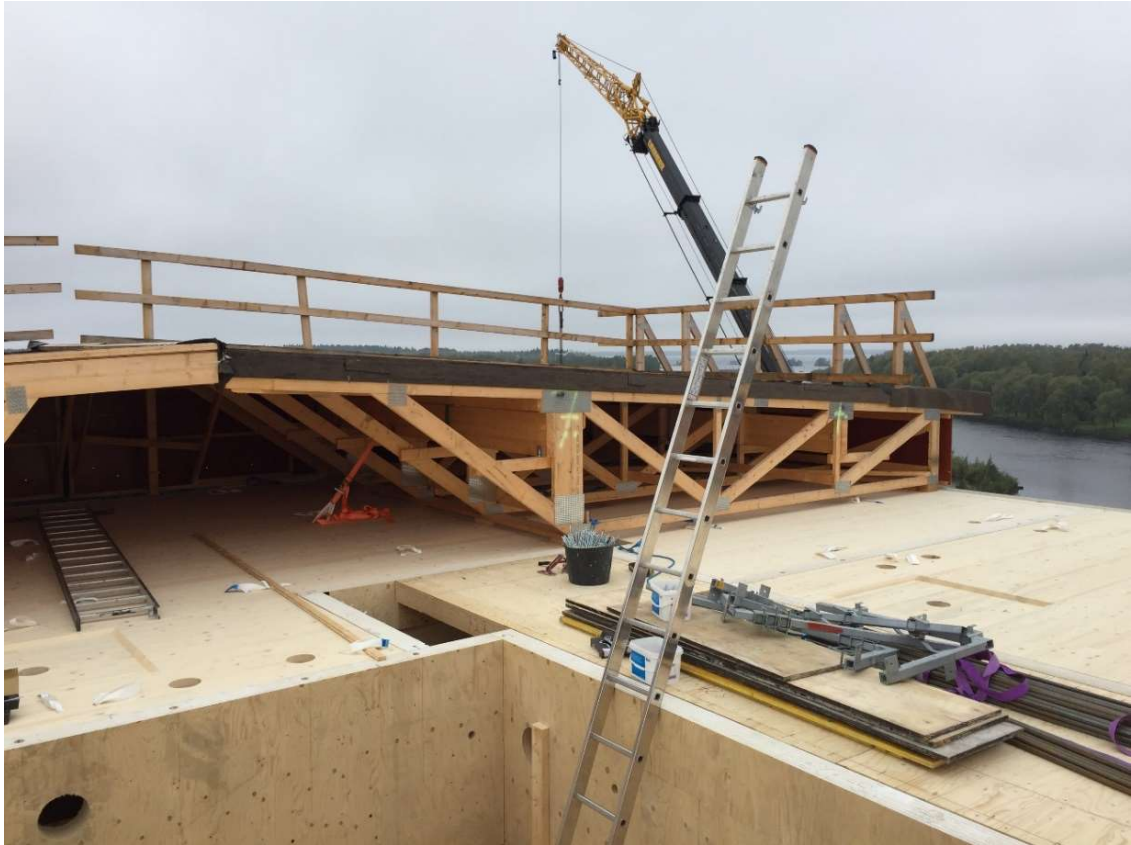
Kuva 44. Väliaikainen sääsuojakatto välipohjan päällä.
