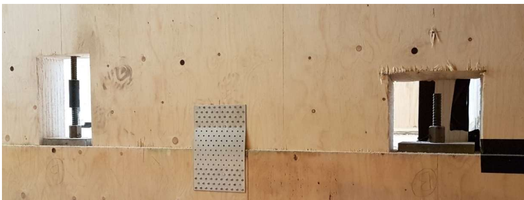
Kuva 52. Jatkuva ja päättyvä jännetanko porrashuoneessa.
