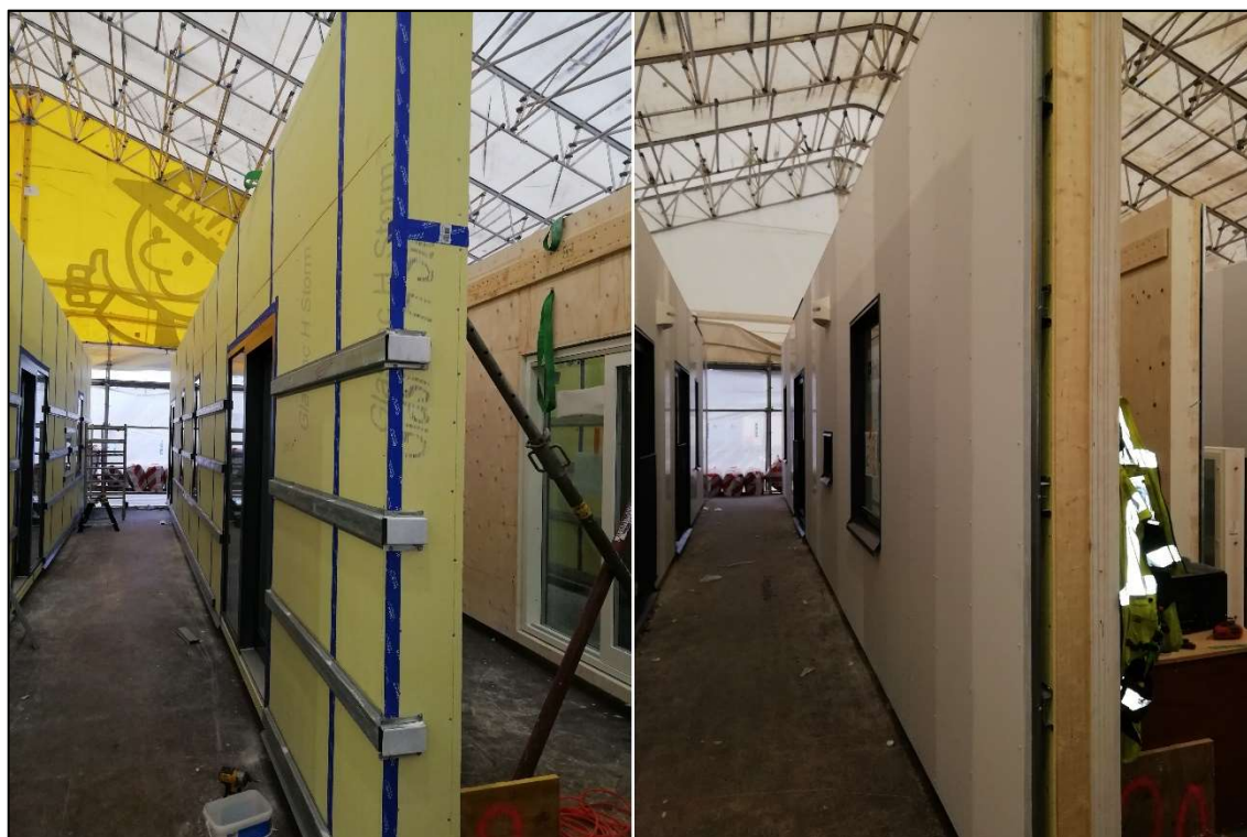
Kuva 61. Vasemmalla kuvassa on kohteen ulkoseinään asennettu Glasroc Storm -tuulensuojalevy ja oikealla on valmiiksi koottu seinäelementti, jossa on Steni Colour -julkisivuverhouslevy paikallaan.
