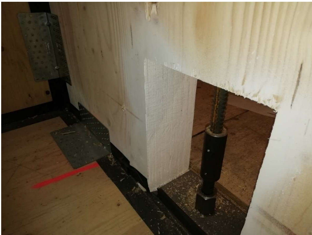
Kuva 72. Väliseinäelementtien sahatut pinnat on käsitelty kosteussulkuaineella.
