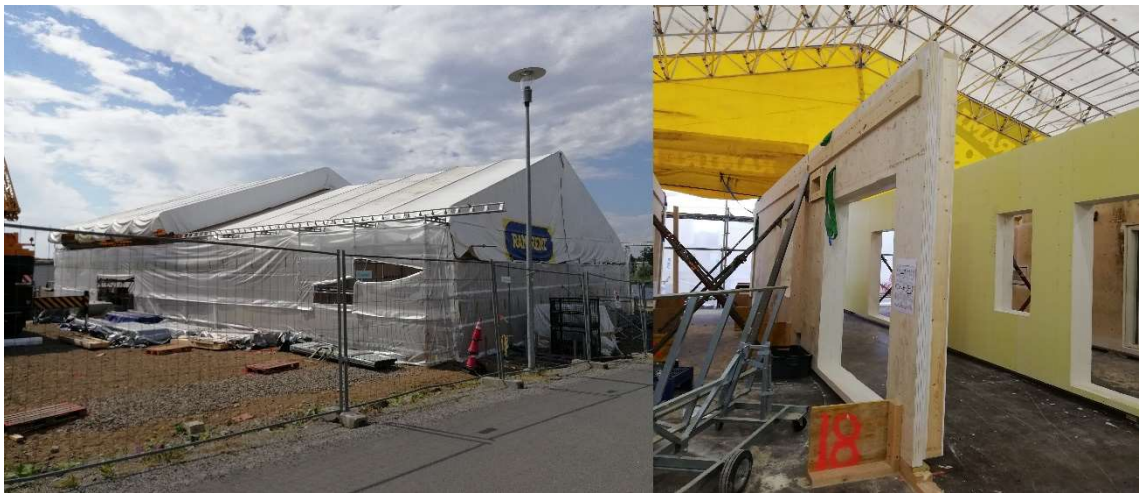
Kuva 73. Ulkoseinäelementit kasataan sääsuojateltassa valmiiksi nostoa varten.
