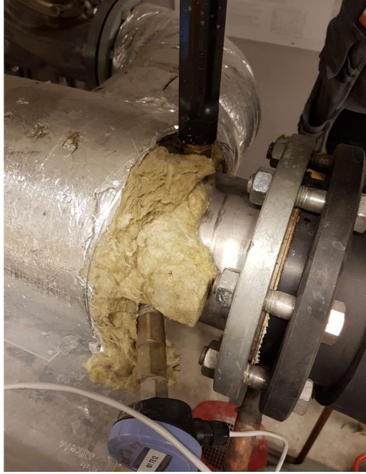
Kuva 36. TE12-vesianturin sijoitus.
