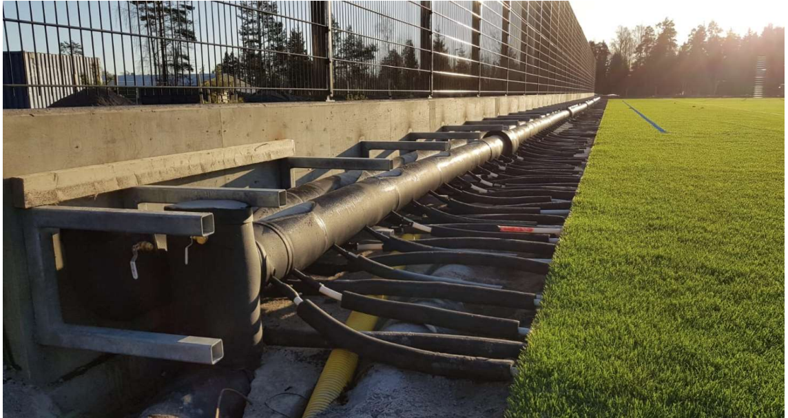
Kuva 32. Toteutunut jakotukkirkatkaisu ennen verhoilua ja liitosten eristämistä.
