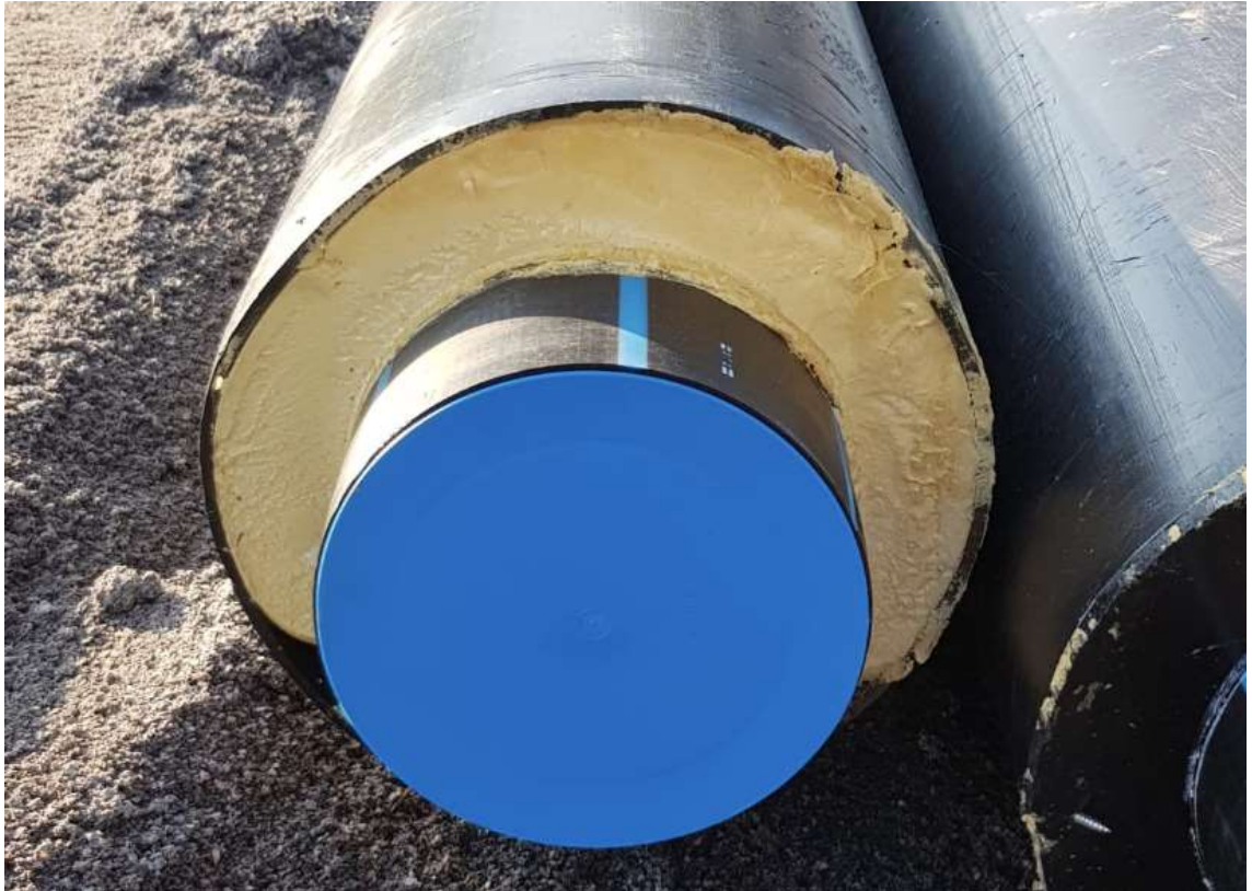
Kuva 16. Kiinnivaahdotettu PEH-siirtoputki Söderkullan urheilukentällä.
