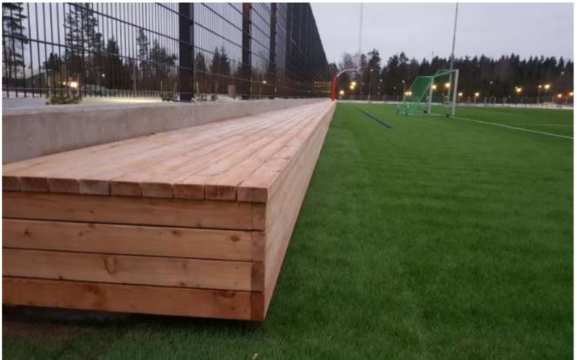
Kuva 33. Toteutunut jakotukkikotelo verhoiltuna.
