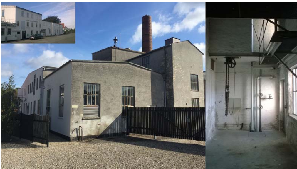
Figur 4. Fabers Fabrikker, en historisk fabriksbyggnad som renoveras med hjälp av 3D-scanning och prefabricerade modulsystem. Foton: Annika Glader.
