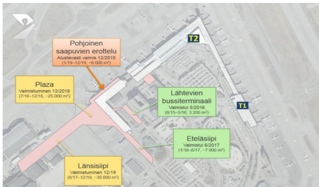
Kuva 1. Ilmakuva laajennusosista Lentokentän hankkeessa (2.)
