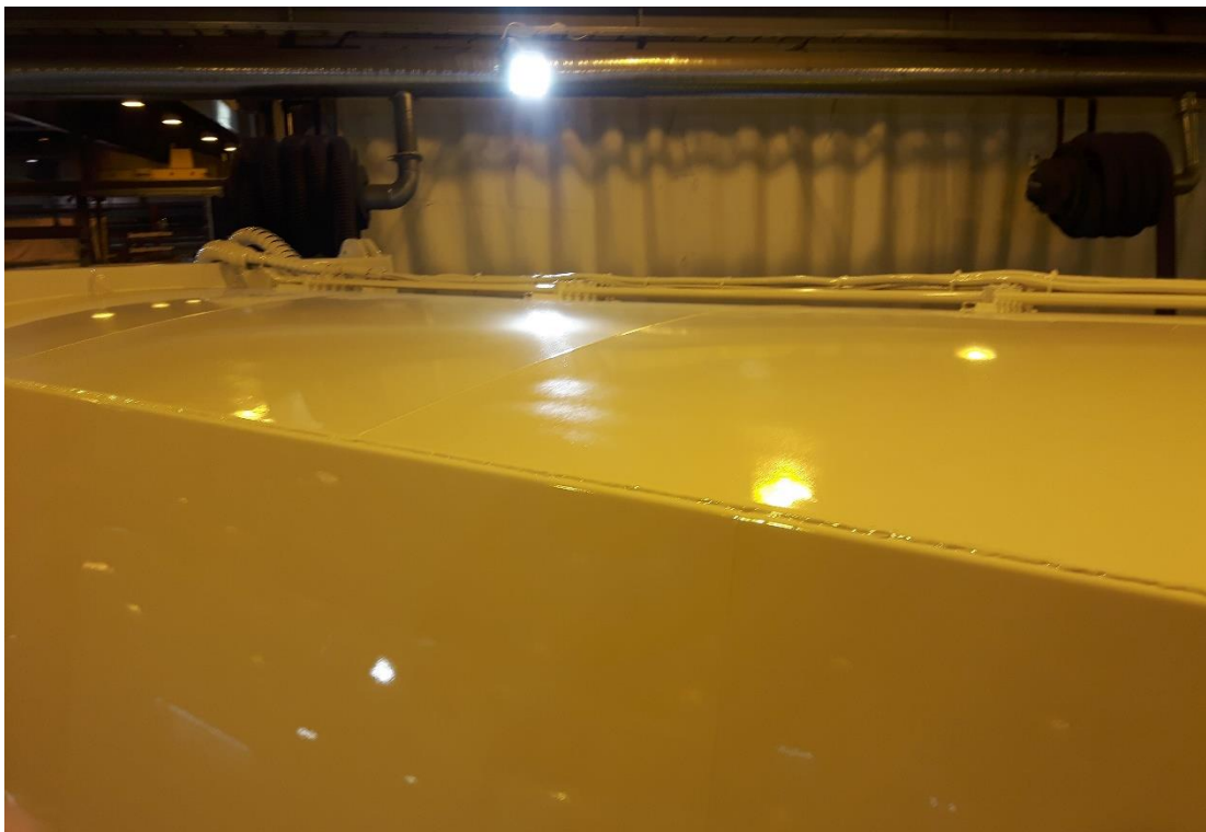
BILD 1. Bild av sopbilens tak (Bilden tagen av Isak Snickars 10.12.2018.)
