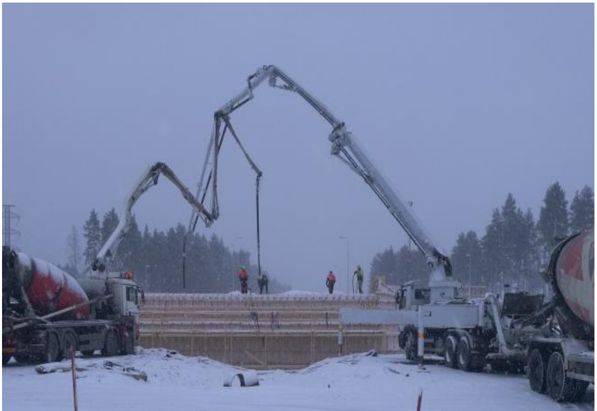
Kuva 6. Sillan betonointia talvella.
