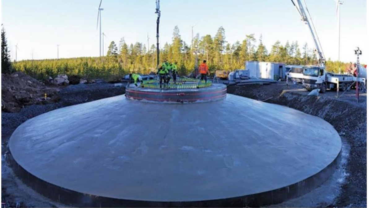
Kuva 5. Tuulivoimalan jalan betonointi (Maastorakentajat 2018).
