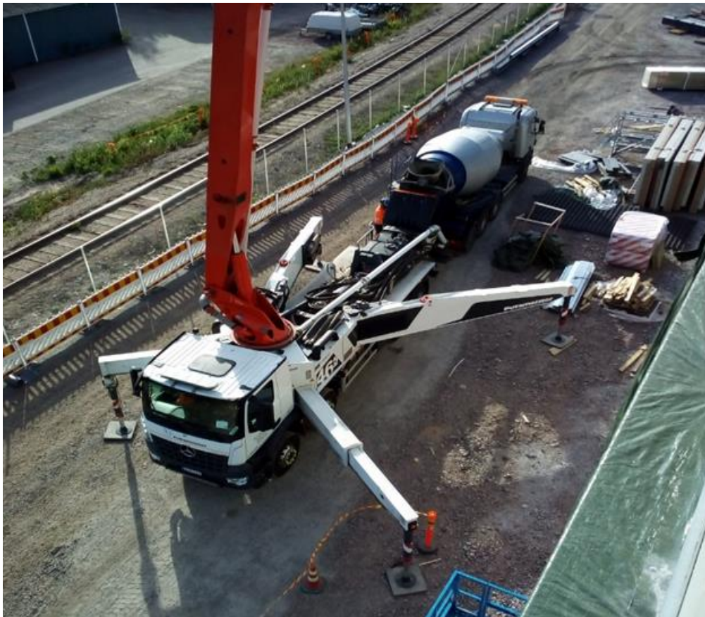
Kuva 2. Pumppauspaikan valinnassa on huomioitava kaluston vaatima tila työmaalla.
