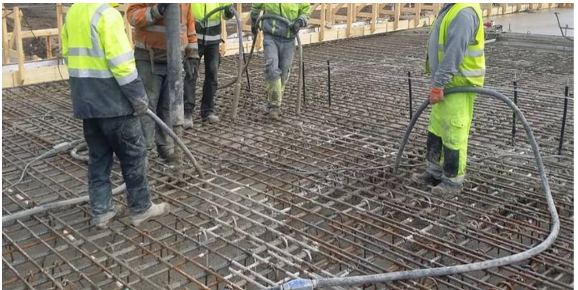
Kuva 4. Betonin tiivistämistä tärysauvoilla.
