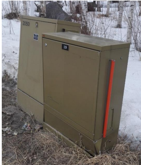
Kuva 3 Vaurioitunut jakokaappi
