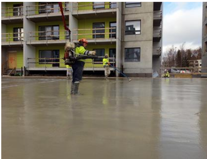
KUVA 8. Jälkihoitoaineen ruiskutus.
