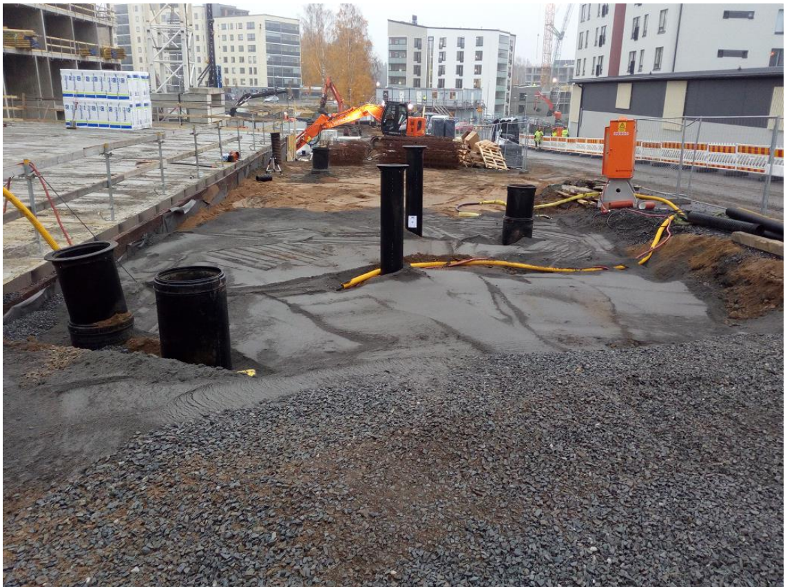
KUVA 17. Parkkihallin vierustäyttö.
