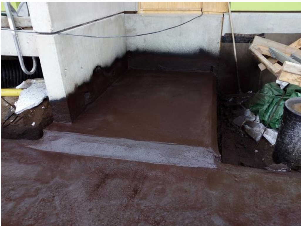
KUVA 12. Ruiskukuminosto parkkihallin ja talon välisen kellarikäytävän päälle.
