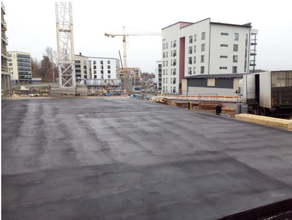
KUVA 16. Parkkihallin kannen 1. lohko vesieristetty.
