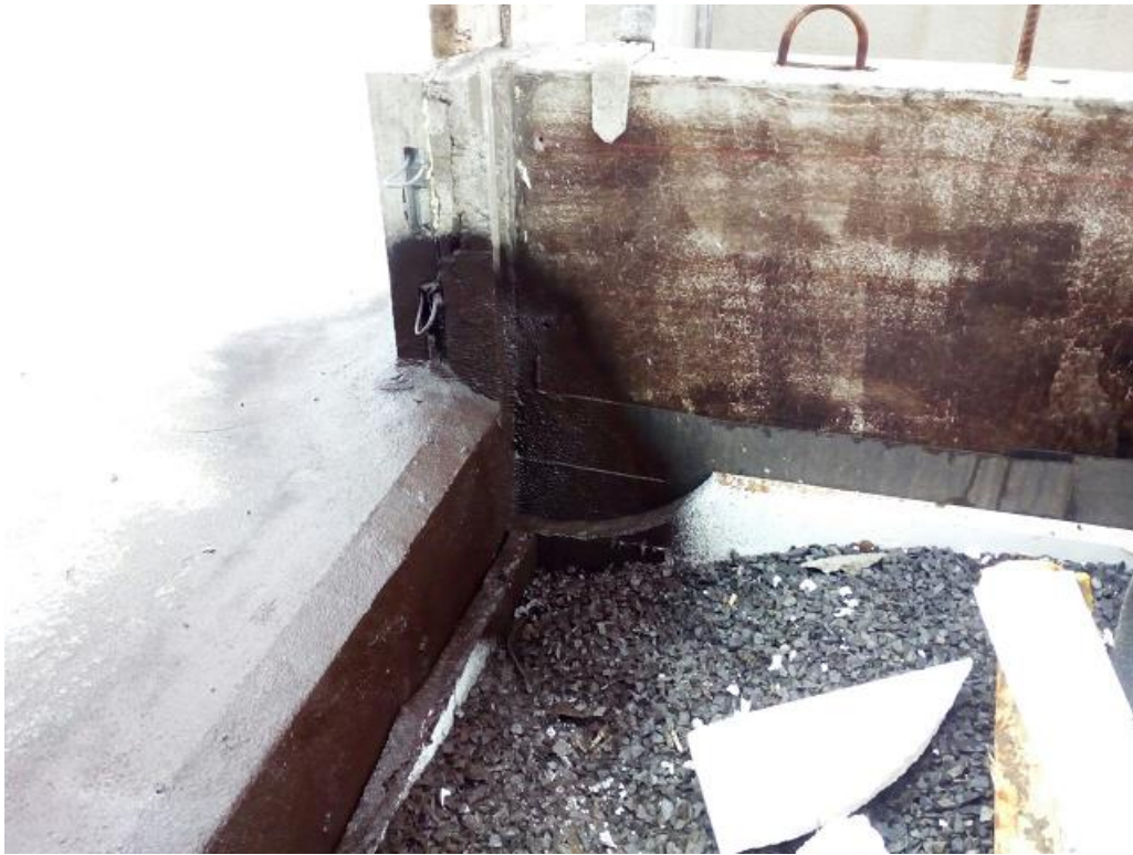
KUVA 13. Ruiskukumin limitys seinän kermieristeen päälle.
