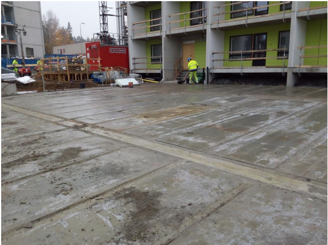
KUVA 4. Ontelolaataston siivous polttomoottorikäyttöisellä harjakoneella ennen kallistusvalua.
