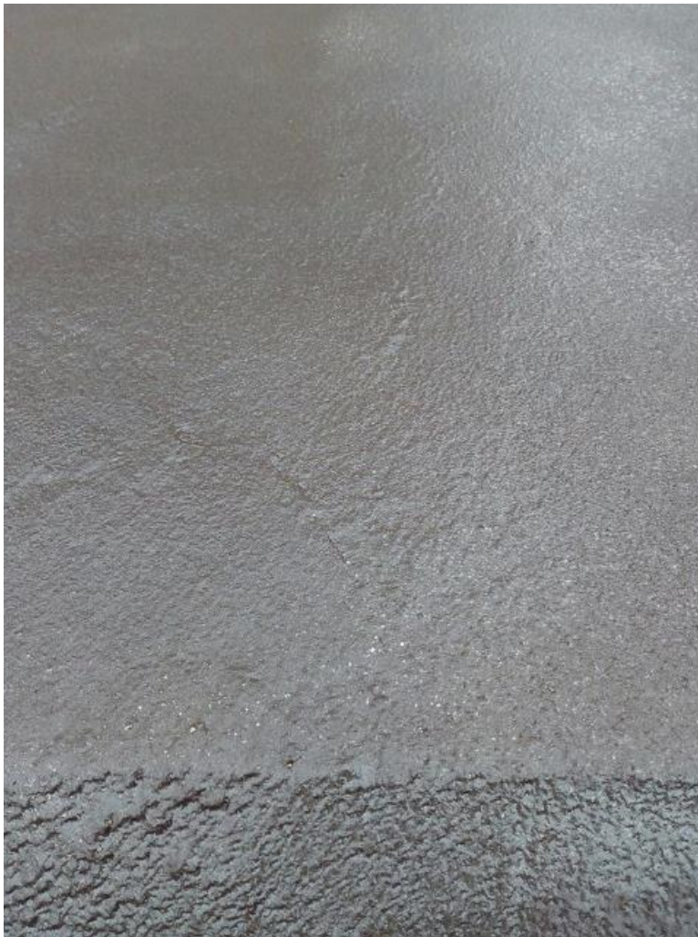
KUVA 15. Valmista ruiskukumipintaa.
