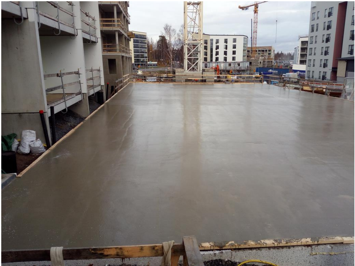
KUVA 9. Valmis kallistusvalu.
