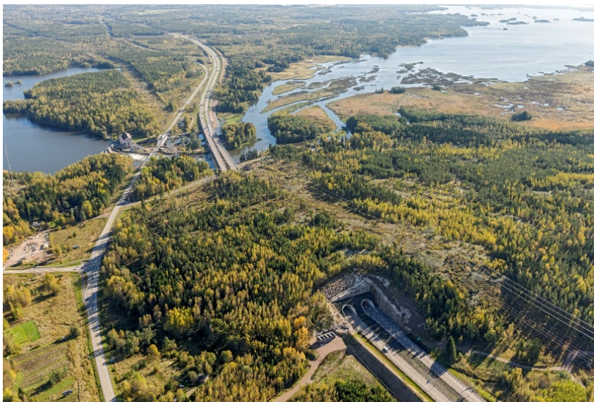
Kuva 1. Markkinmäen tunneli Kotka-Koskenkylän moottoritieellä
