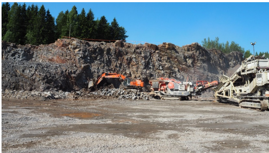
Kuva 7 Koskenkylän esimurskain ja louhittu kallio.
