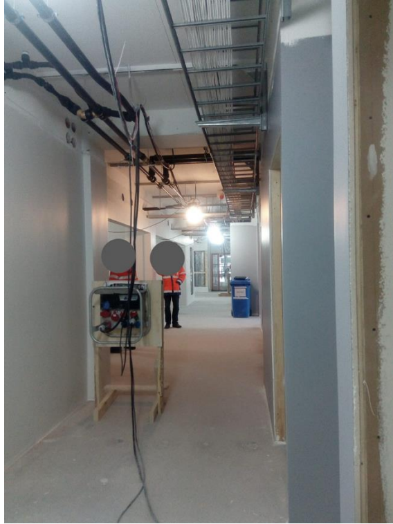
Kuva 5. Ilmanvaihdon asennusalue ennen asennusten alkamista.
