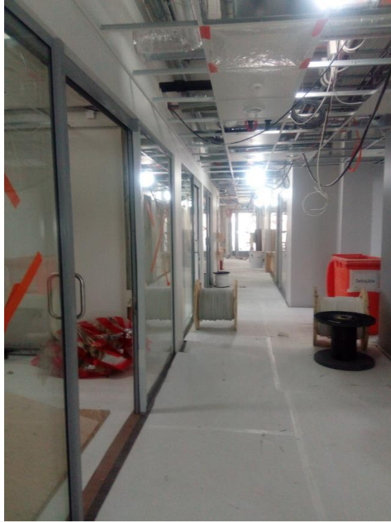
Kuva 15. Työmaatilanne myöhemmin kerroksissa.
