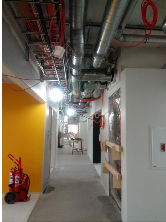
Kuva 12. Tilanne kerroksessa IV-asennusten jälkeen.
