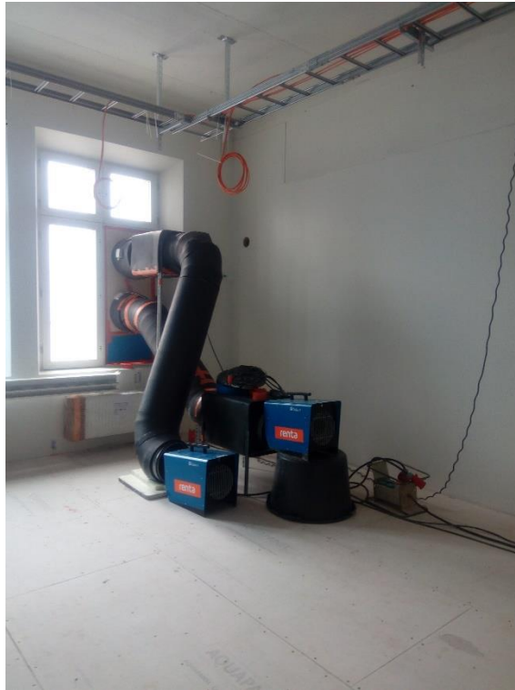
Kuva 7. Ilmanvaihdon asennusten aikainen puhallinjärjestelmä.
