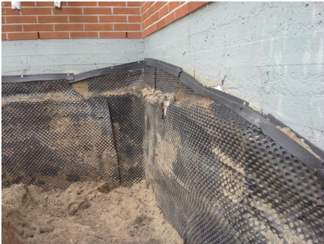
KUVA 4. Vanhan patolevyn tarkastus
