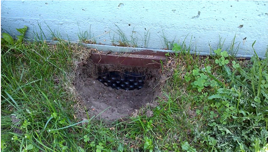
KUVA 5. Patolevyn kunnan tarkastus
