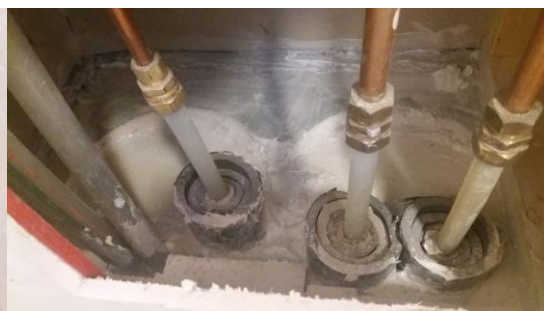
KUVA 12. Alapohjan tiivistetty aukko
