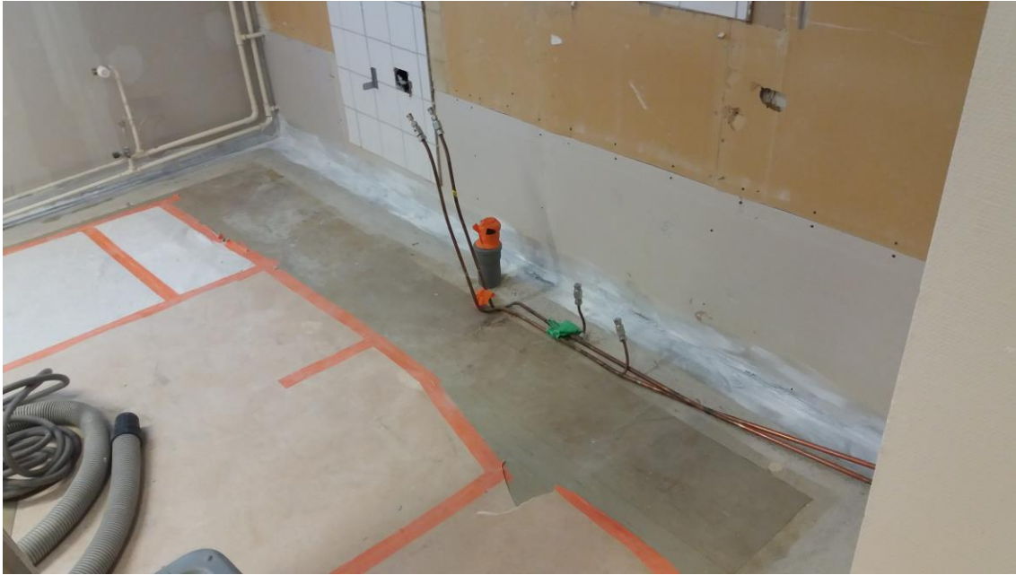
KUVA 9. Seinän ja lattian liitoksen tiivistäminen
