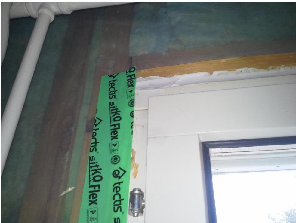
KUVA 6. Ikkunan ja seinän liittymän tiivistäminen
