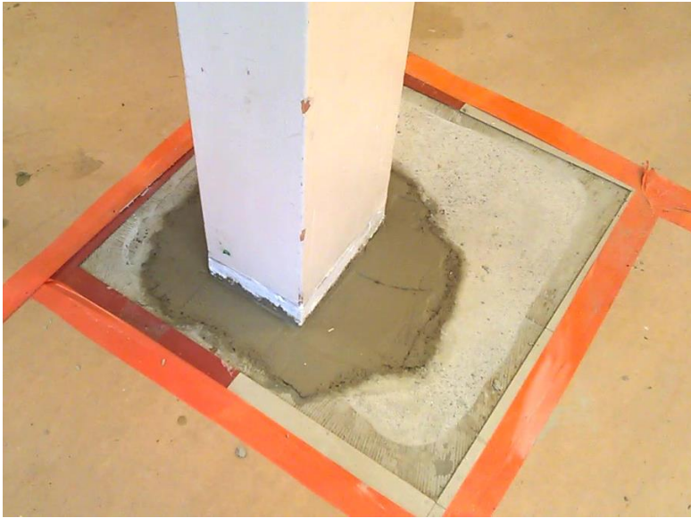
KUVA 10 Alapohjan lävistävä pilari
