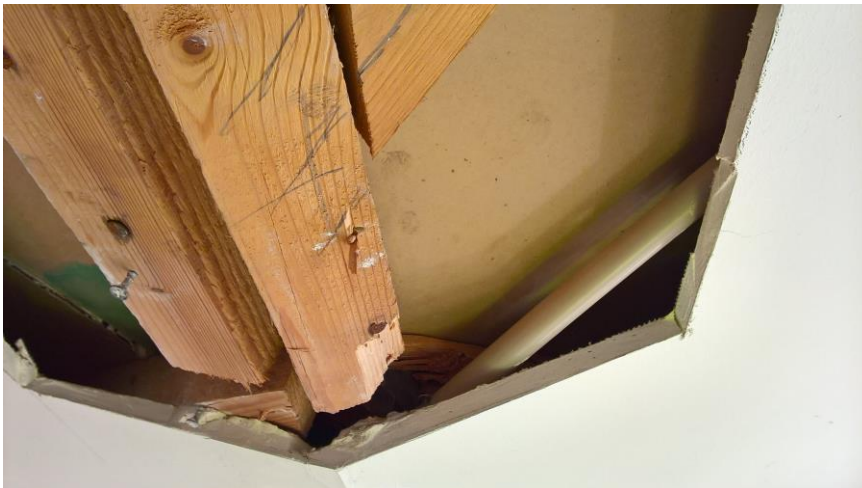
KUVA 13. Yläpohjan kunnan tarkasteluaukko
