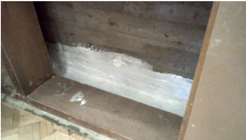
KUVA 14. Monitoimisalin seinän ja alapohjan liitos
