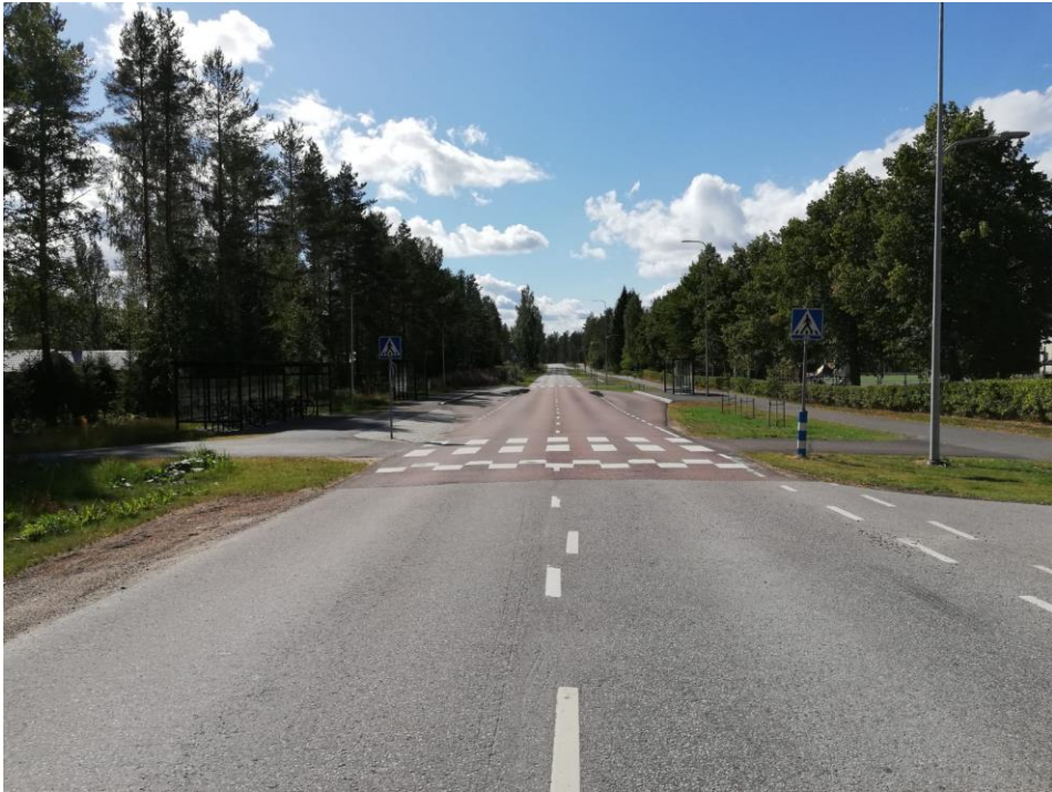
Kuva 14. Koulukatu saneerauksen jälkeen. Luonetjärven koulu oikealla.
