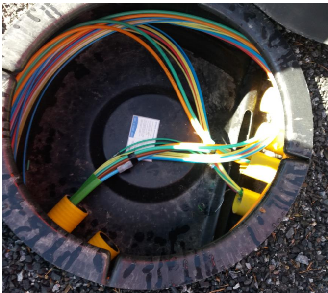
Kuvio 73. Mikroputkijatkos muovikaivossa
