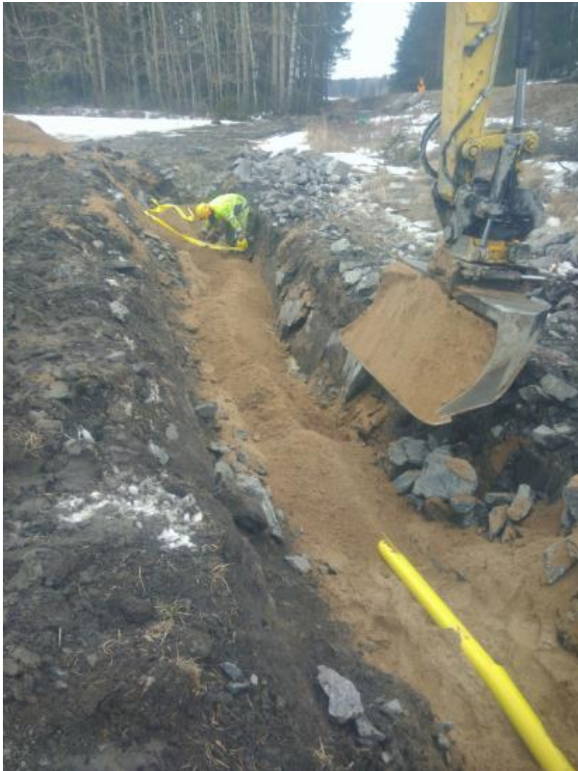
Kuvio 46. Kaapelikaivannon esitäyttöä ja varoitussauhan levitystä (Turpeinen, M. 2018)
