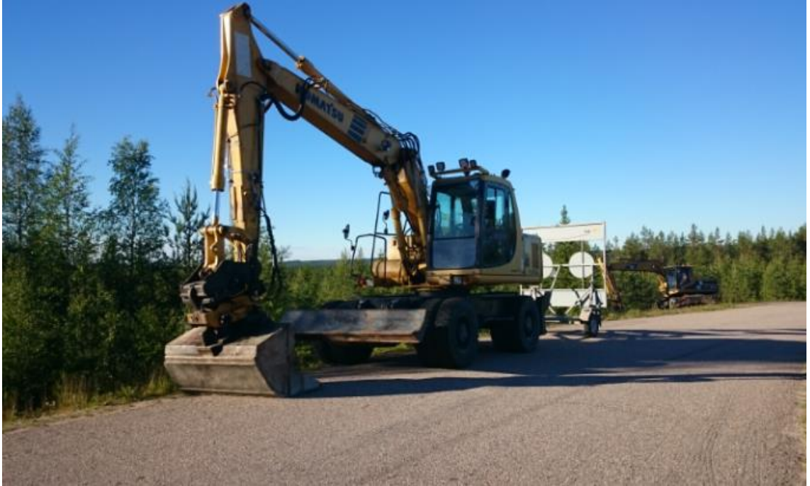
Kuvio 47. Peittelykoneena toimiva pyöräalustainen kaivinkone, jonka takana liikenteenohjausvaunu
