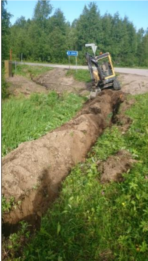
Kuvio 44. Kaapelikaivantoa ELY:n tiealueella
