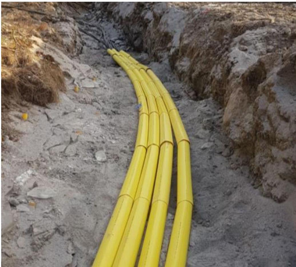
Kuvio 45. Kaapeleita suojattuna muovikourulla (Turpeinen, N. 2018)
