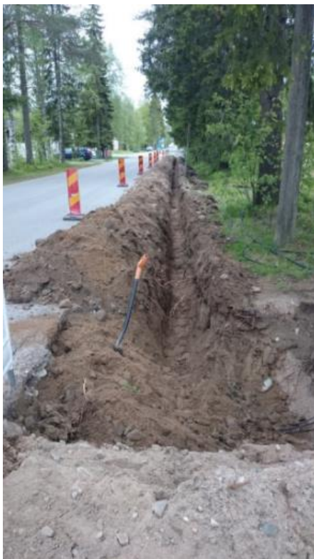
Kuvio 43. Kaapelikaivantoa taajama-alueella
