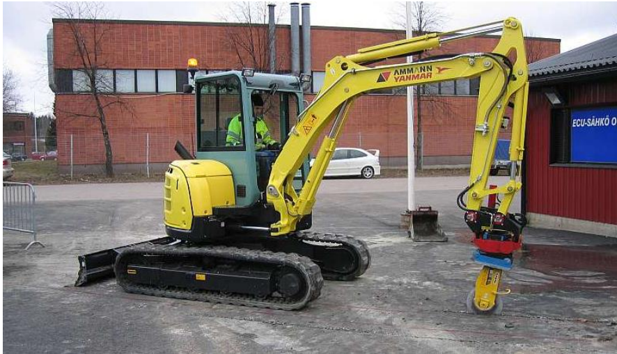
Kuvio 51. Asfaltin leikkuuta kaivinkoneeseen tarkoitettulla asfalttileikkurilla (Nupumies)
