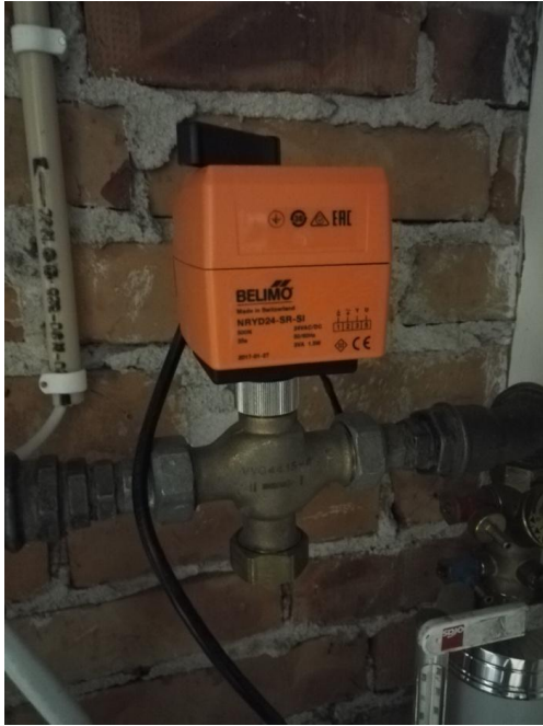
Kuva 16. Belimo-venttiilisäätömoottori ilmanvaihtokonehuoneessa
