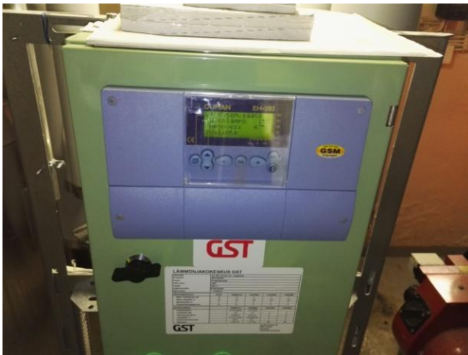
Kuva 5. Ouman EH-203, lämmityksen säädin
