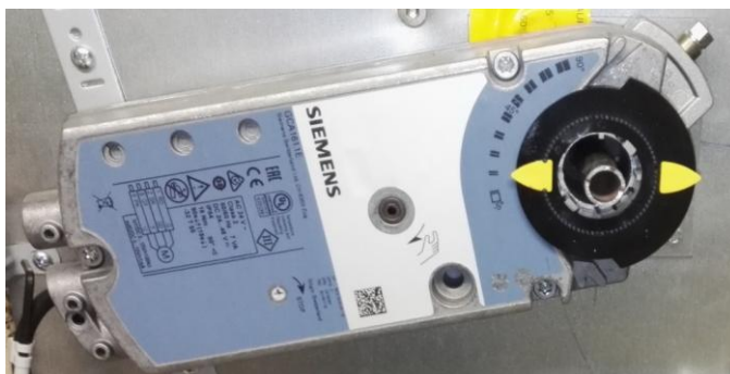
Kuva 15. Siemensin GCA 161.1E -peltimoottori
