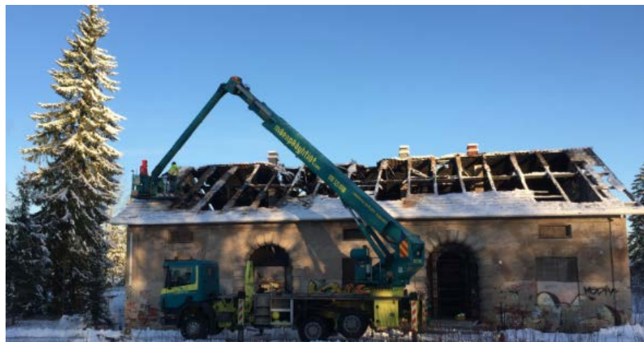
Kuva 8. Eteläisen katon lappeen purkutyöt joulukuun 2017 (Nuutinen 2017)
