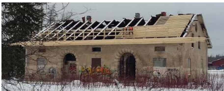
Kuva 9. Ruodelautojen laitto helmikuu 2018 (Nuutinen 2018)
