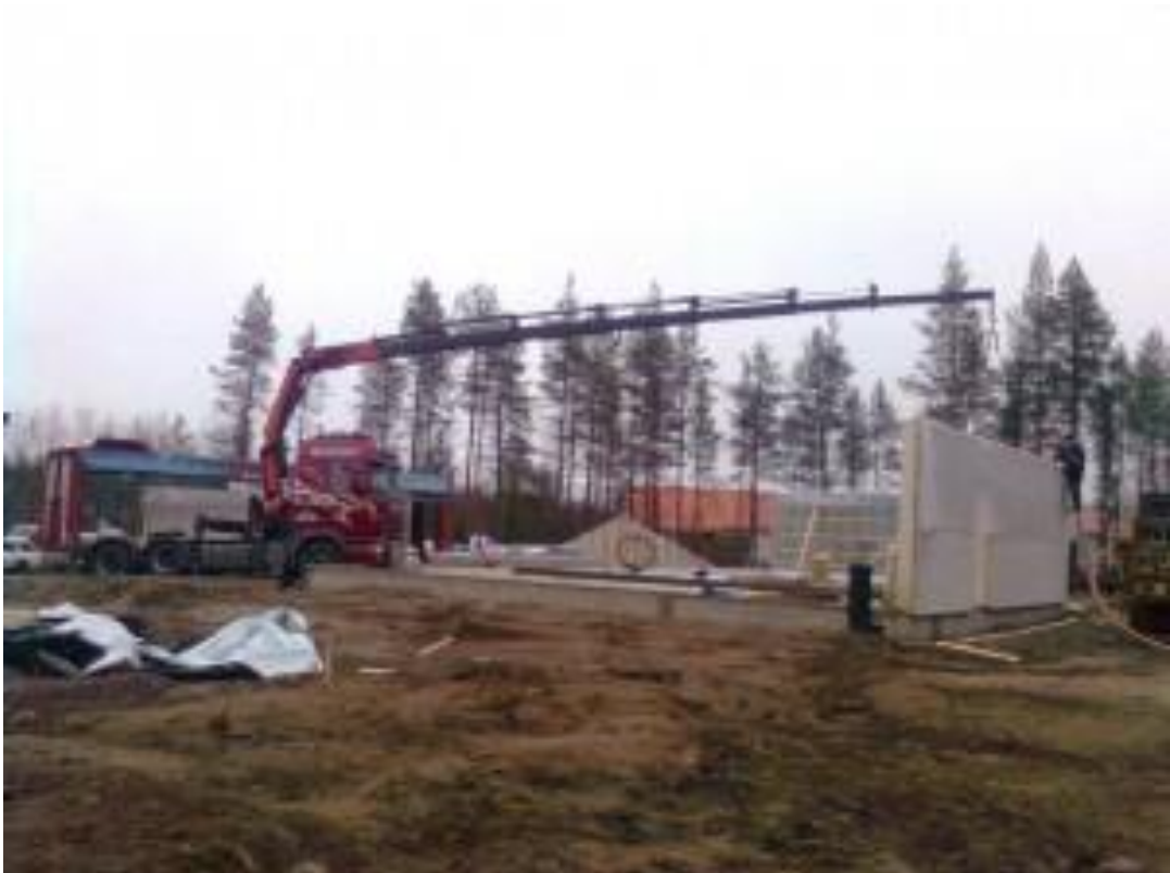
Kuva 7. Talon pystytys (Pohjaset Oy 2018.)
