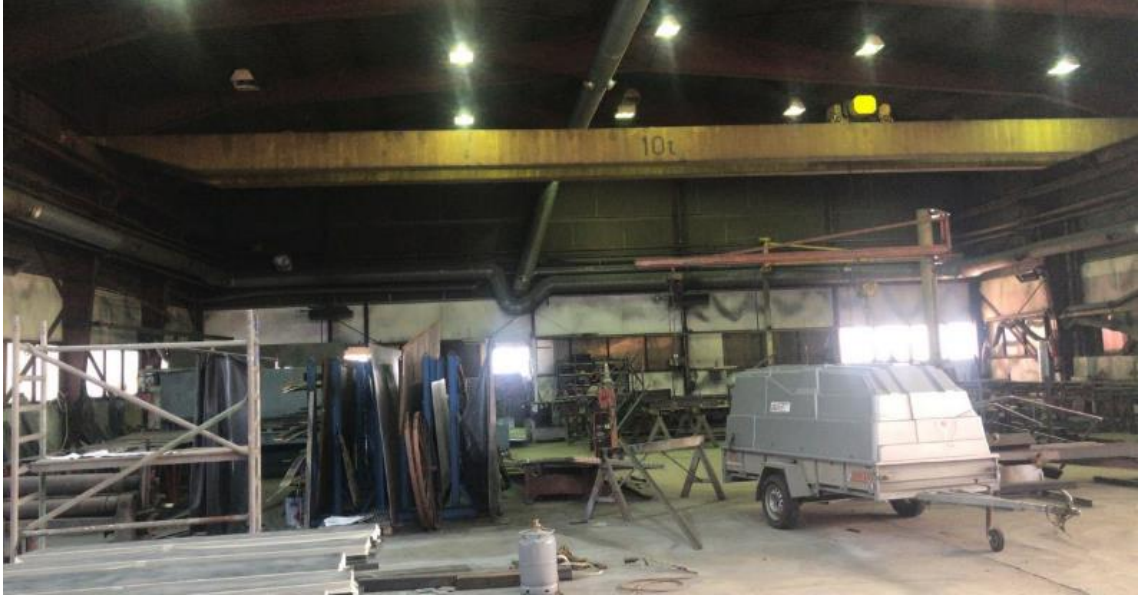
Kuva 5. Kuvassa tuotantohallin alkuosa, jossa katon alaslasku
