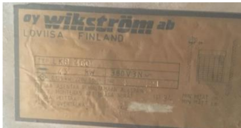
Kuva 12. Tyyppikilpi IV-koneen lämpöpatterin kyljestä
