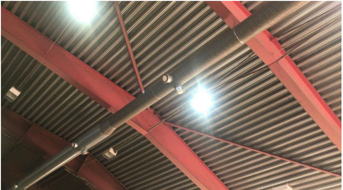
Kuva 6. Kuvassa hallin jatko-osan liitos poistoputkessa
