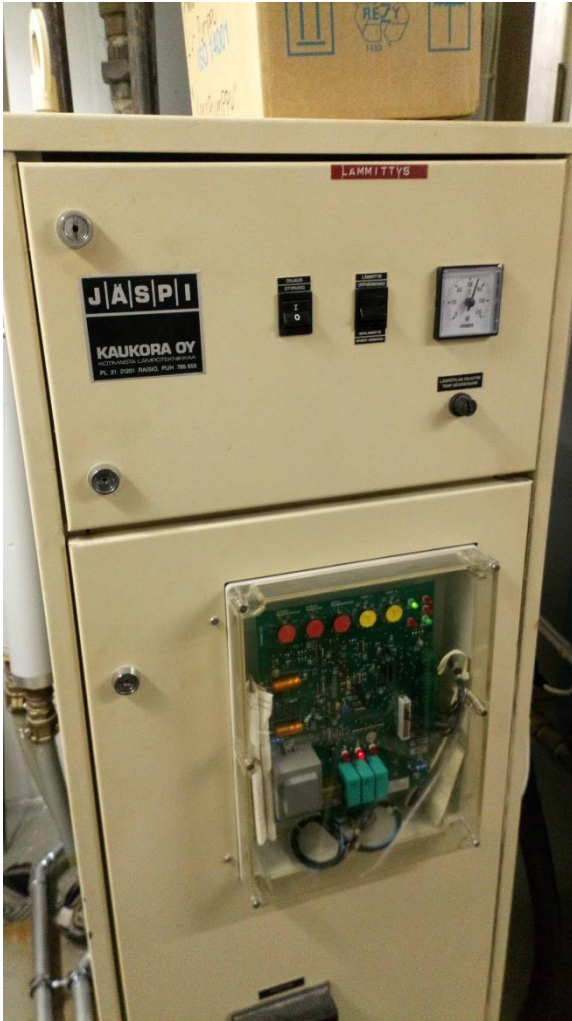
KUVA 2 Kiinteistön nykyinen lämmöntuotantolaitteisto
