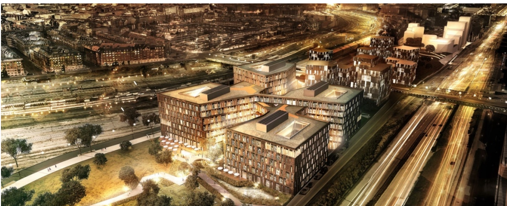
Figure 55. Exterior 'De Fire Styrelser' (Arkitema, 2014)
