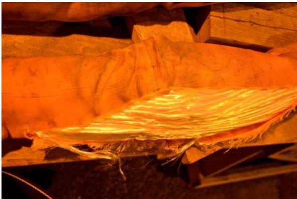
Kuva 6 Langat sulaminen lämpövaurion johdosta
