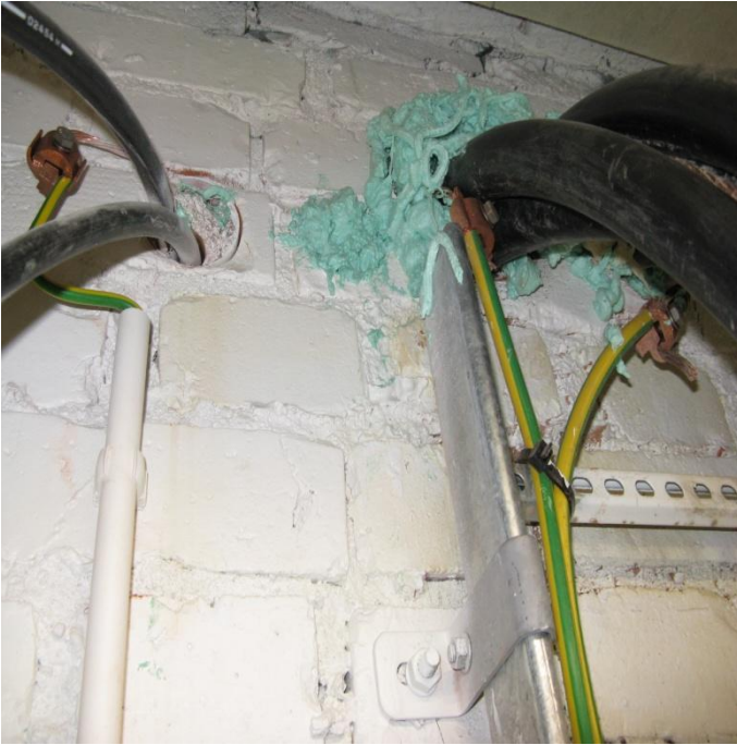
Liitäntä laajaan maadoitusverkkoon
