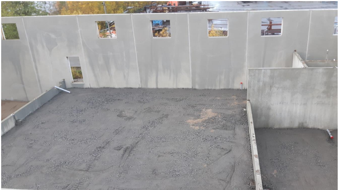
Kuva 6. Kuva hallin sisäpuolelta, huomaa korkoerot.
