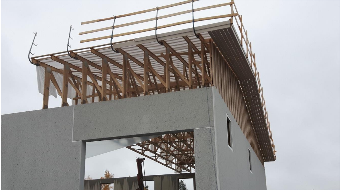
Kuva 4. Ensimmäinen lohko asennettuna.
