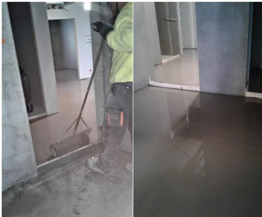
Kuva 11. Tasoitteen tiivistämistä rissalla ja juuri levitettyä tasoitetta.
