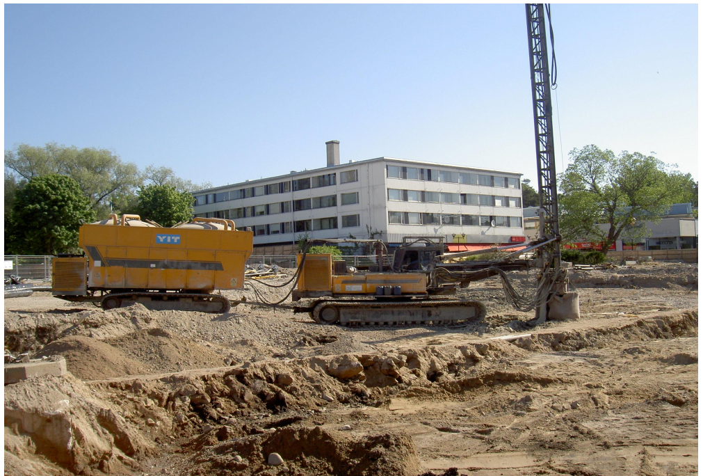
Kuva 2. Pilaristabilointikone
