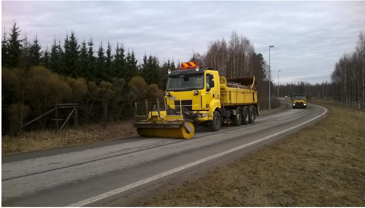
KUVA 6. Harjaustyötä kuorma-autolla ja avoharjalla
