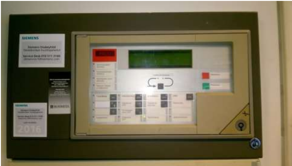
Kuva 2. Pohjankartanon koulun paloilmoitinjärjestelmä (kuva: Niko Mursu)
