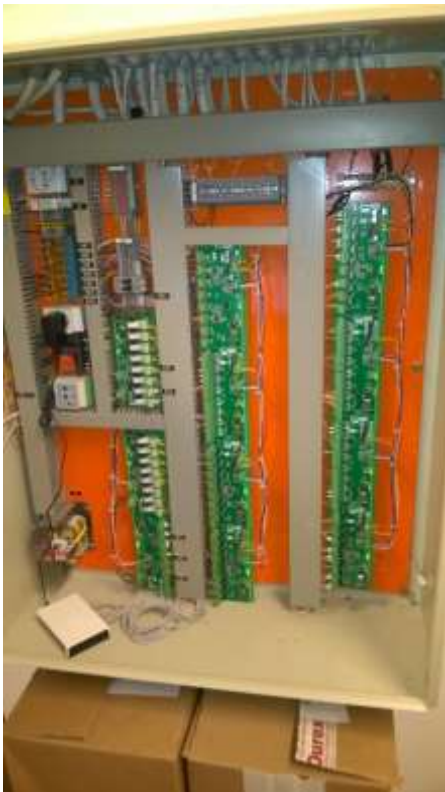
Kuva 3. Pohjankartanon koulun automaatiojärjestelmä (kuva: Niko Mursu)
