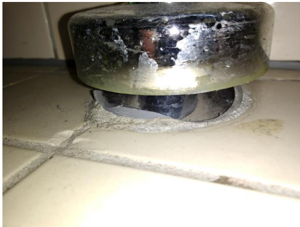
Kuva 12. Lavuaarin viemäroinnin läpivienti
