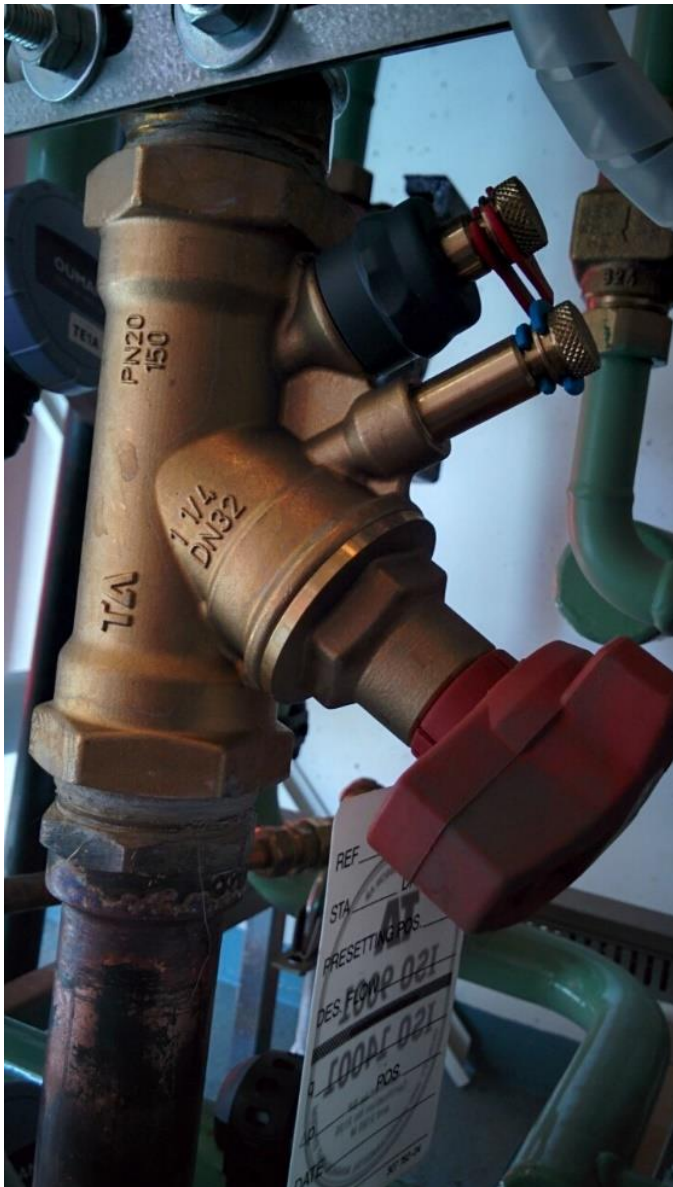
Kuva 8 Linjasäätöventtiili kohteessa (Juho Hesso, 2017)
