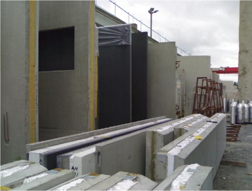
Kuva 5. Mustissa pesubetonielementeissä havaittua sävyeroa tehtaalla (Antti Savinainen 2010)
