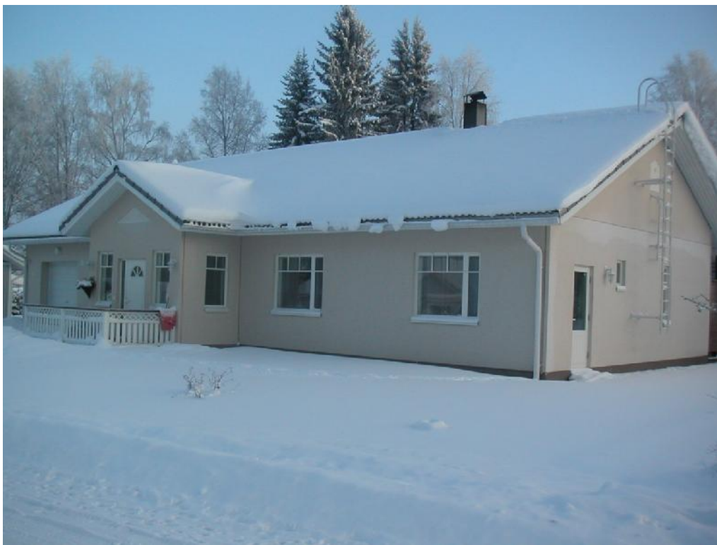
Kuva 3. Vaaleankeltaisista ja ruskeista pesubetonielementeistä toteutettu omakotitalo Siilinjärvellä (Antti Savinainen 2010)
