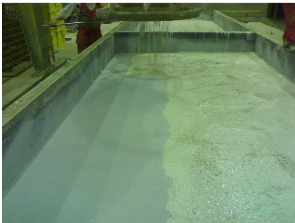
Kuva 8. Valkobetonin levitystä muottiin hidastinaineen päälle (Antti Savinainen 2012)
