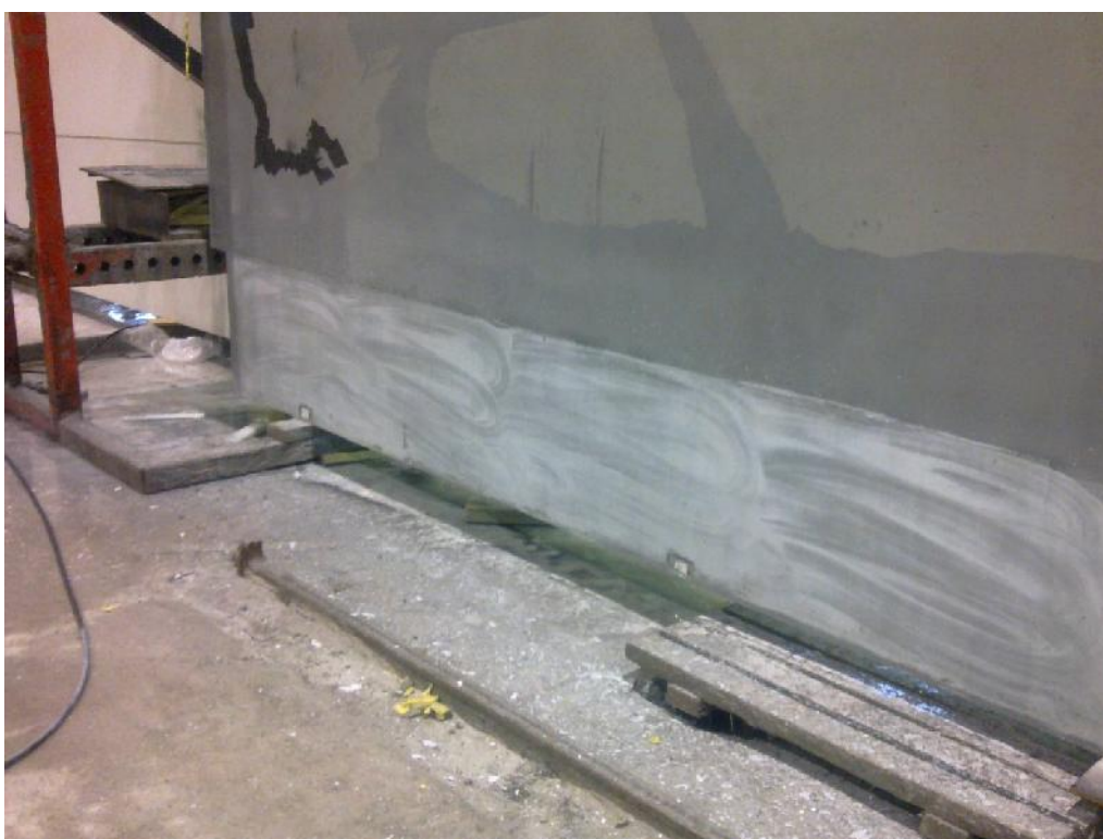
Kuva 10. Huolimattomasti levitetyn muottiöljyn pyyhintäjäljet valmiissa väribetonipinnassa (Antti Savinainen 2013)
