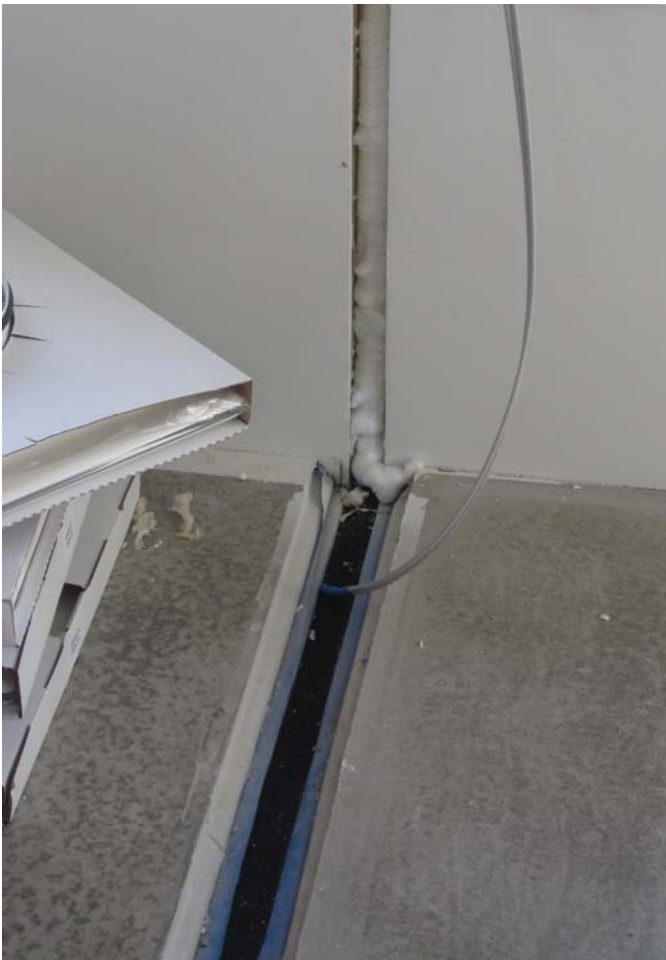
Kuva 9: Tilaelementtien välinen liitos Tremcon tuotteilla. (Emmi Alitalo)
