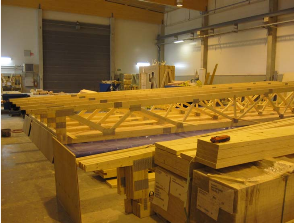
Kuva 16: Vesikaton tekoa 2009 (Emmi Alitalo)
