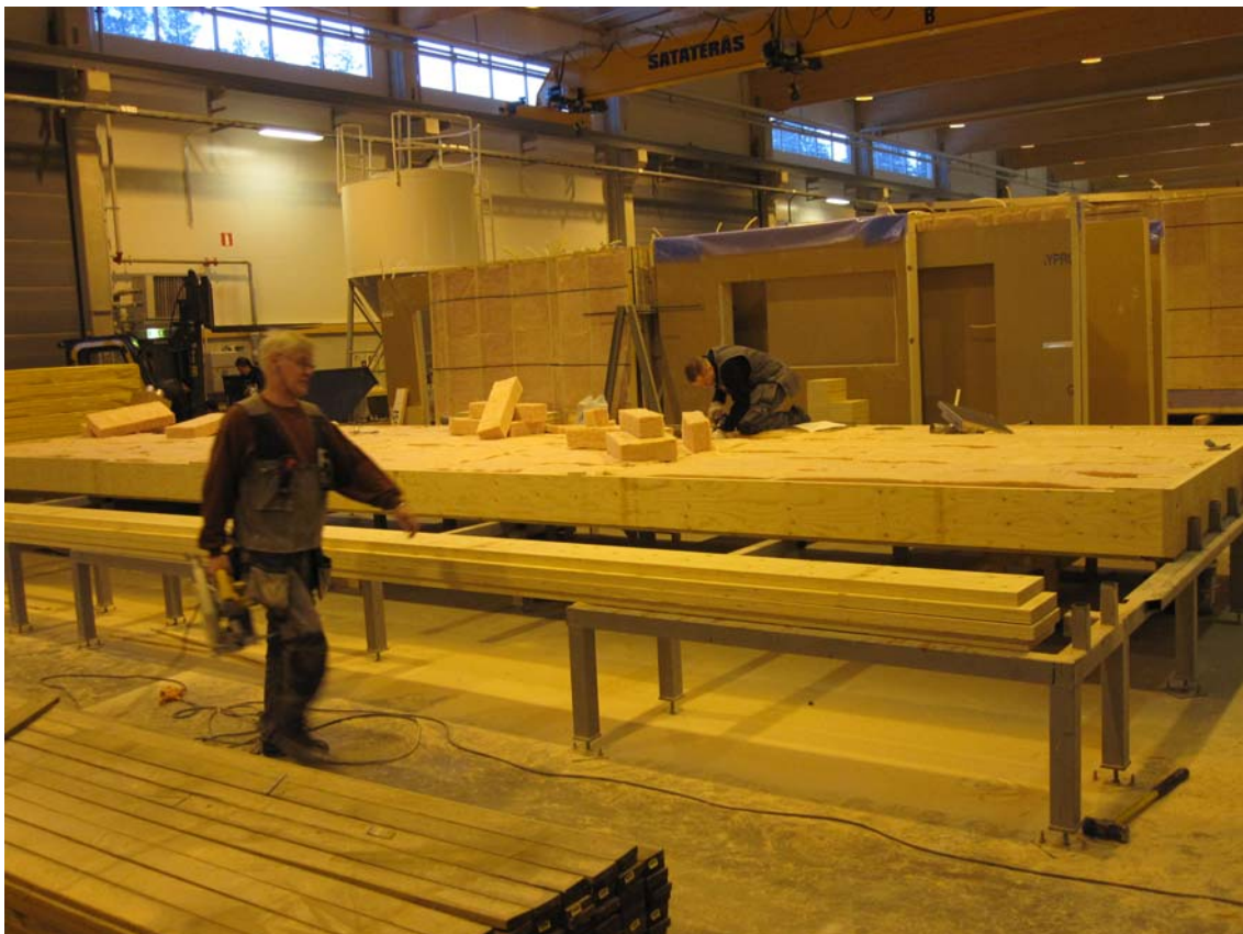
Kuva 12: Alapohjan tekoa 2009 (Emmi Alitalo)
