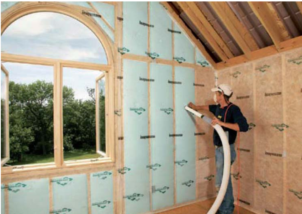
Kuva 19: Blow-in-Blanket- järjestelmä (Knauf Insulation)
