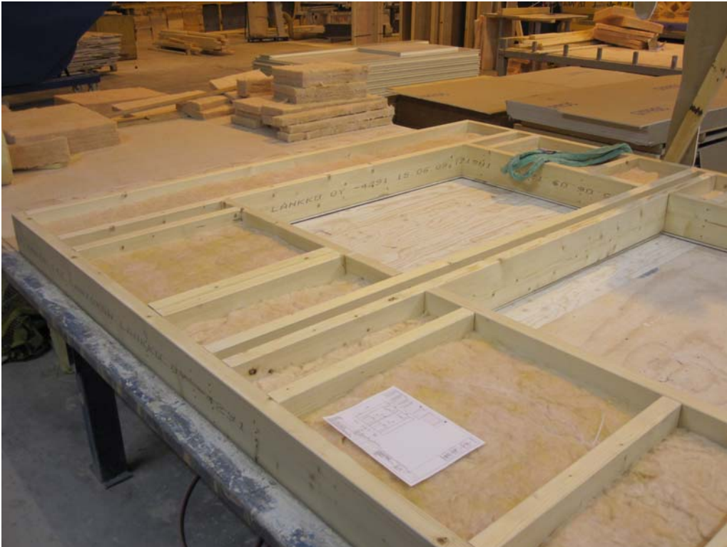
Kuva 14: Ulkoseinän tekoa 2009 (Emmi Alitalo)
