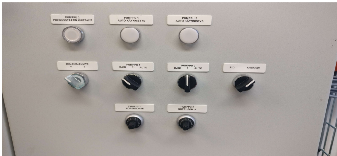
Kuva 5. Pumppujen käyttökytkimet sekä nopeusohjepotentiometrit.
