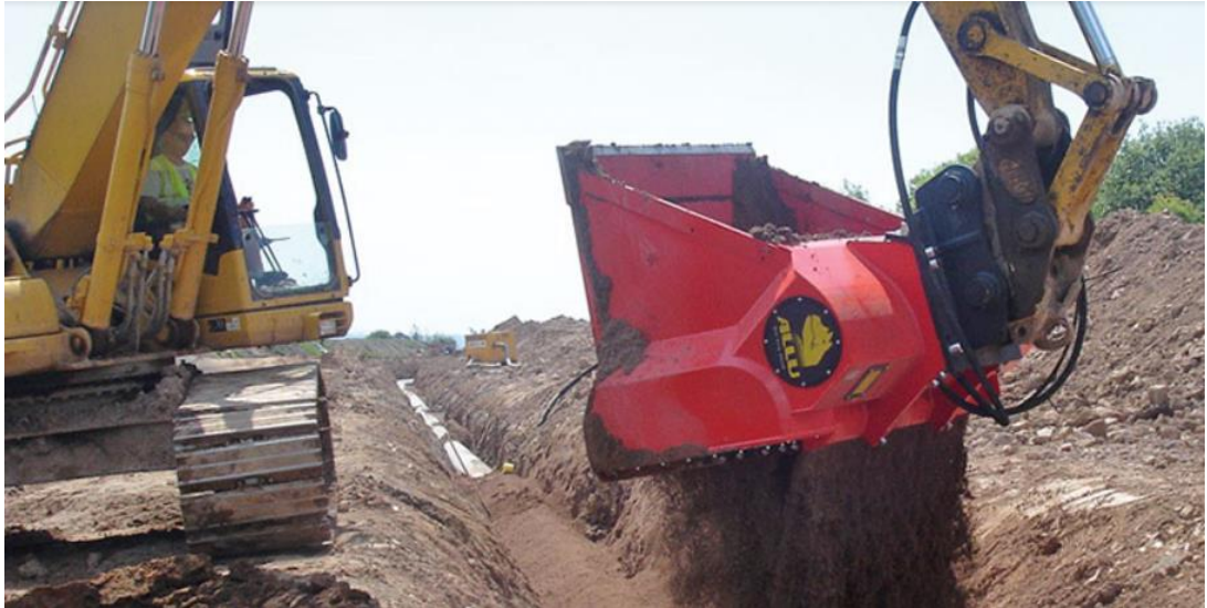
Kuva 6. Seulakauha putkikaivannon täytössä. [16]
