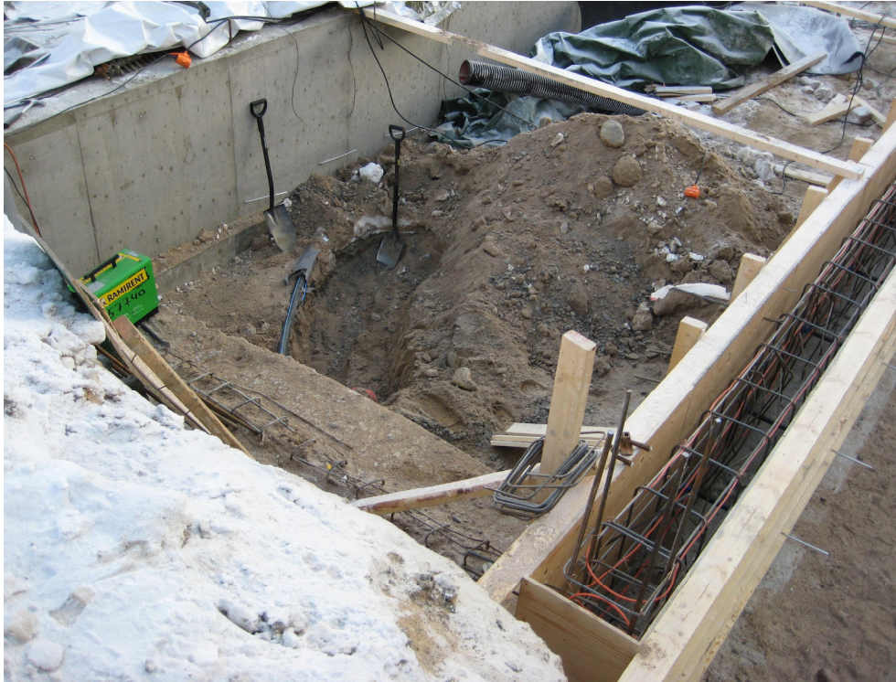
Kuva 11. Lankalämmitys asennettuna raudoitukseen.
