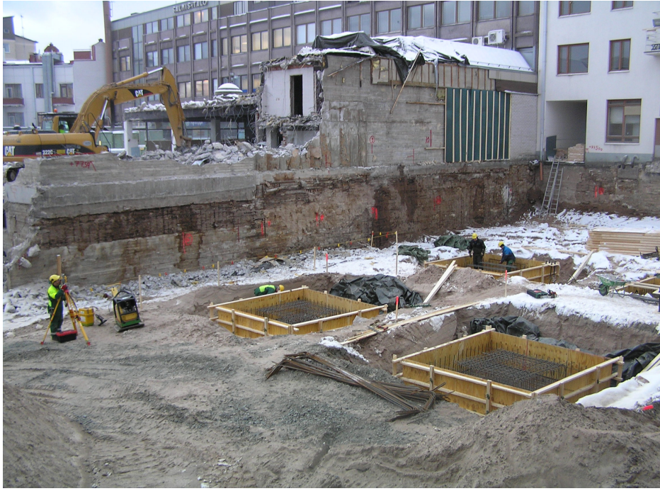
Kuva 16. Turvallinen työmaa. Lumen alle ei ole jäämässä turhia tavaroita.
