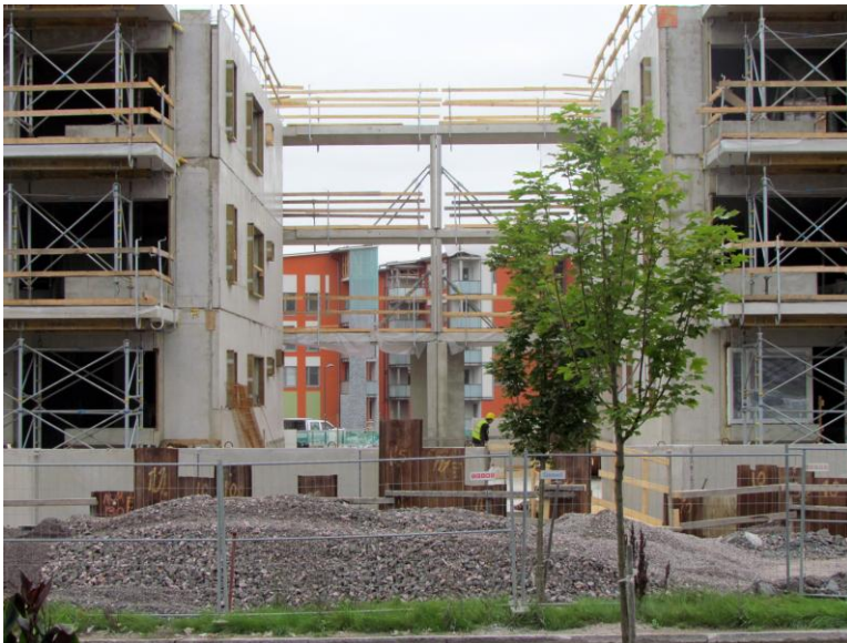
Kuva 1 Suurpeltoa rakennetaan syksyllä 2012
