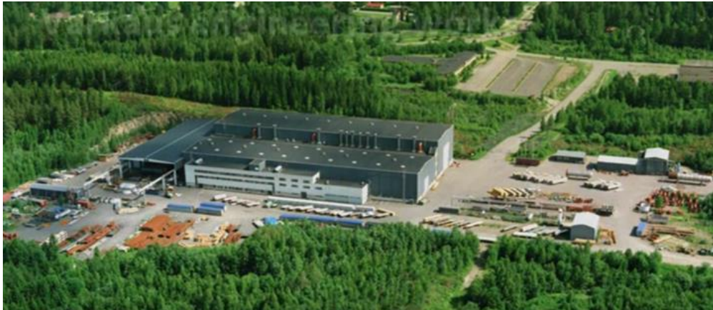
KUVA 1. Sahala Works Oy tuotantohalli (Sahala Works Oy esittelyvideo, Liitetty 17.12.2016, saatavissa: https://www.youtube.com/watch?v=5y80yaZWlmg )
