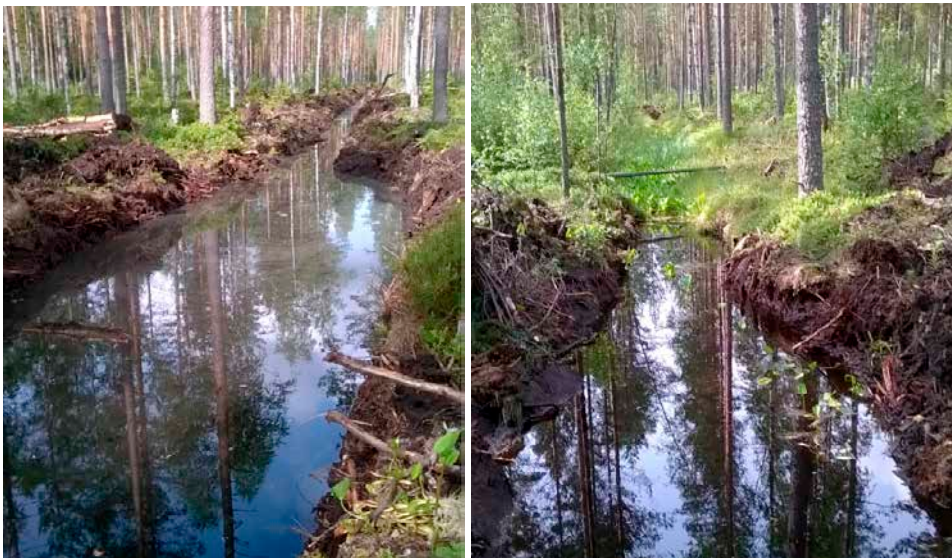
KUVA 2. Kurkimäen kohde kunnostuksen jälkeen (kuvat Tuija Ranta-Korhonen).
