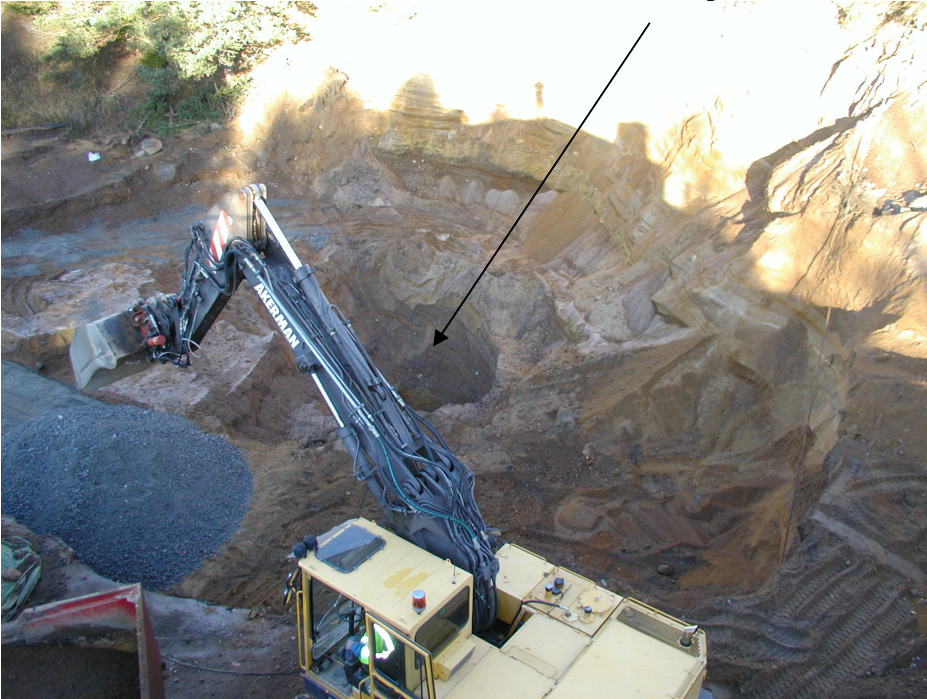
Kuva 2. Pilaantuneen maa-aineksen kaivua – Huomioi pilaantuneen kerroksen ohuus
