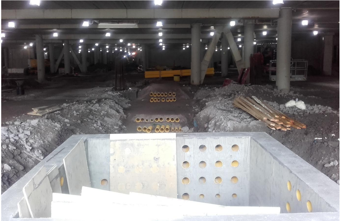
Kuva 8. Edellispäivänä valettu sähkövetokaivo, joka on odottamassa putkien asennusta.
