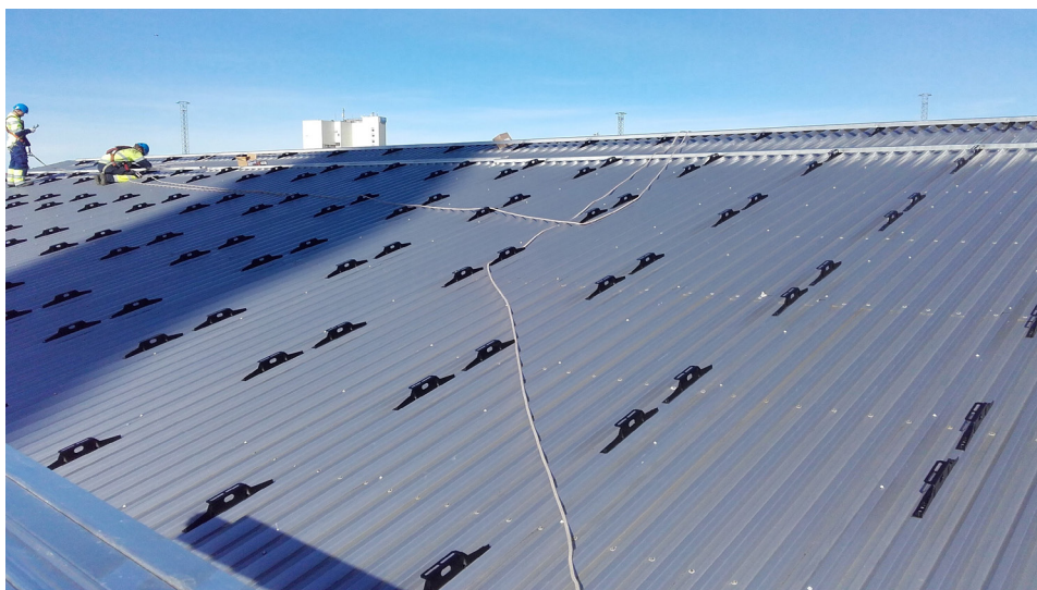
Kuva 16. Pinnoitetut hiiliteräksiset kattokiinnikkeet (lumiasteiden kiinnikkeet).
