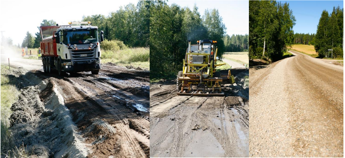
Kuva 27. Kastelu vasemmalla, tiivistys ja valmis pinnoitettu tie oikealla.
