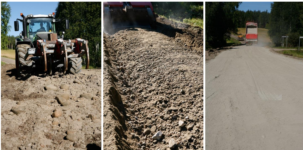
Kuva 24. Runkoaineen murskaus vasemmalla ja keskellä. Oikealla sementin levitys tielle.
