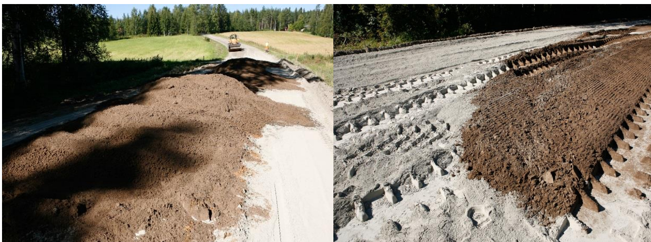
Kuva 25. Sementtikerroksen päälle tuotu tuhka ennen levitystä.
