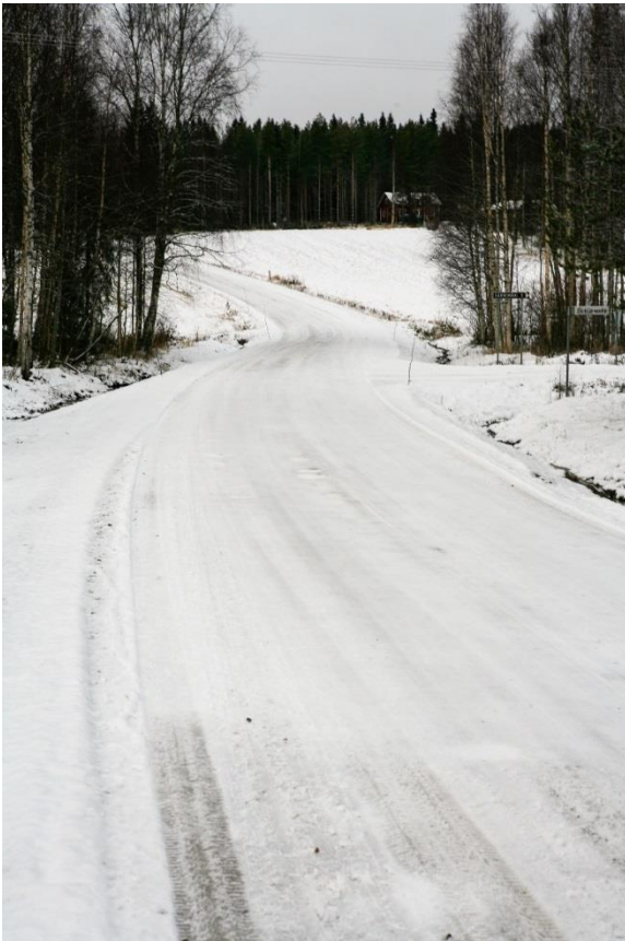
Kuva 33. Biotuhkaseoksella stabiloitu tieosuus marraskuussa 2015.
