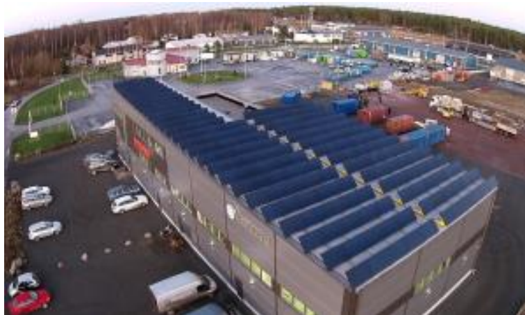
Kuva 9. Aurinkosähköpaneelit Koy Aurinkopajan katolla. /34/
