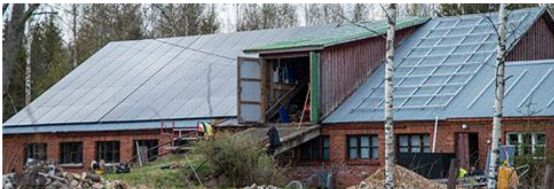
Kuva 10. Aurinkopaneelit asennusvaiheessa sikalan katon lappeella /40/.
