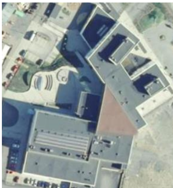
Kuva 9. Vuores-talon paneeli-rivit eteläpuoleisella katolla.
