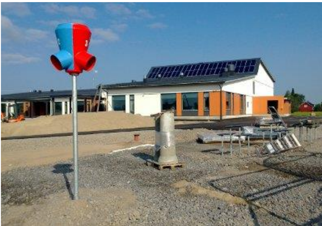
Kuva 11. Koulun kattoon integroitu aurinkokeräinkenttä /43/.
